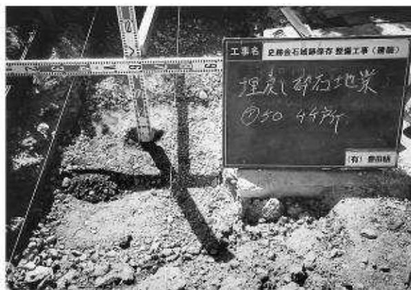
写真218 基礎砕石施工状況
