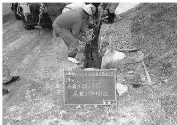
写真178 石積水路施工状況
