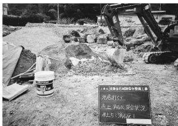
写真150 赤土・消石灰混合状況
