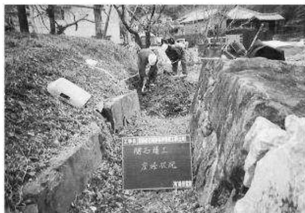
写真215 腰石積施工状況
