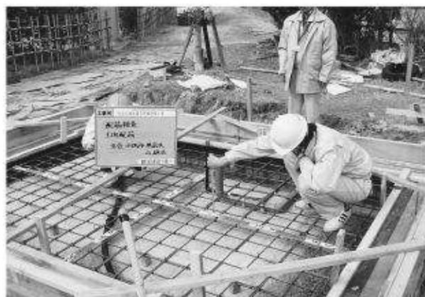
写真253 土間配筋検査状況
