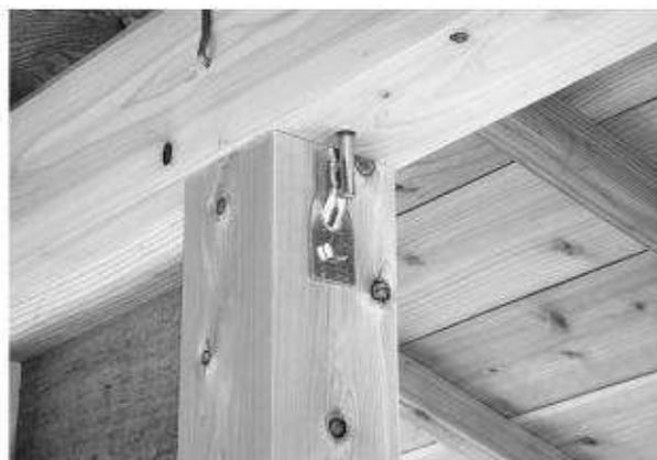
写真260 羽子板ボルト設置状況
