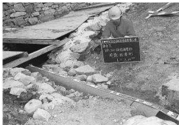
写真163 暗渠管B (VP300) 完了
