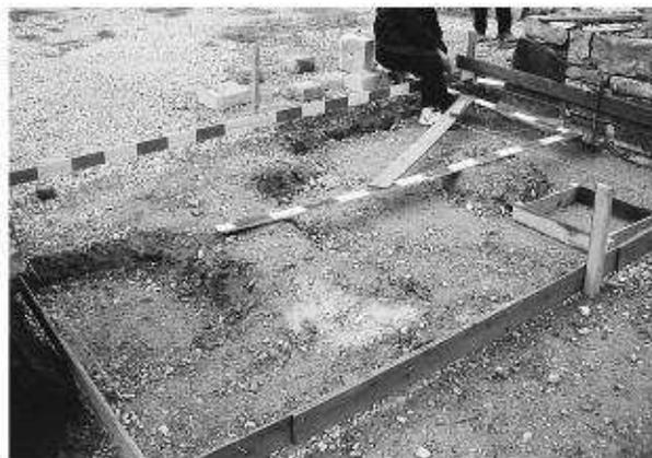
写真226 基礎碎石施工状況
