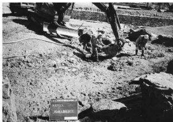
写真146 堆積土撤去状況
