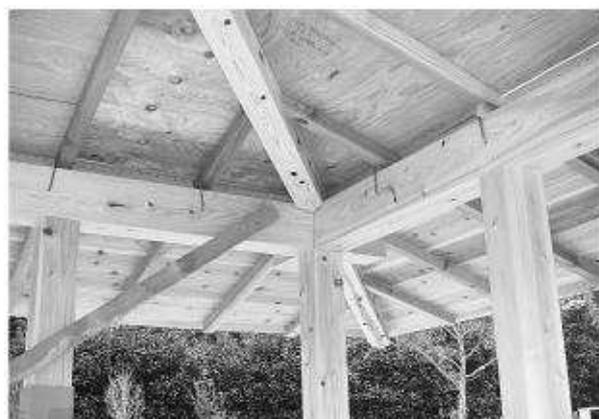
写真261 ひねりかすがい設置状況
