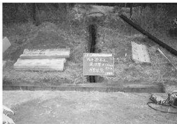
写真192 暗渠管φ100設置状況
