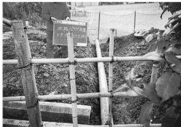
写真185 暗渠管 VP150設置状況
