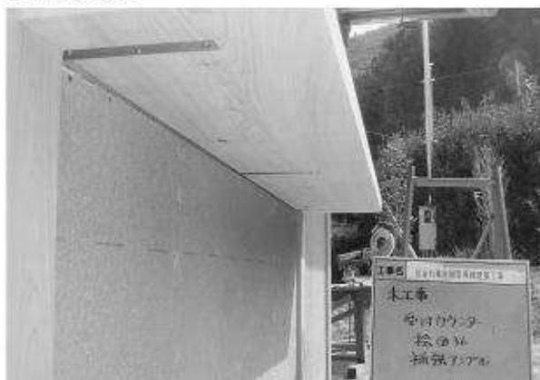
写真265 補強アングル設置状況
