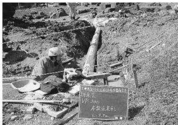
写真164 暗渠管C (VP300) 設置状況
