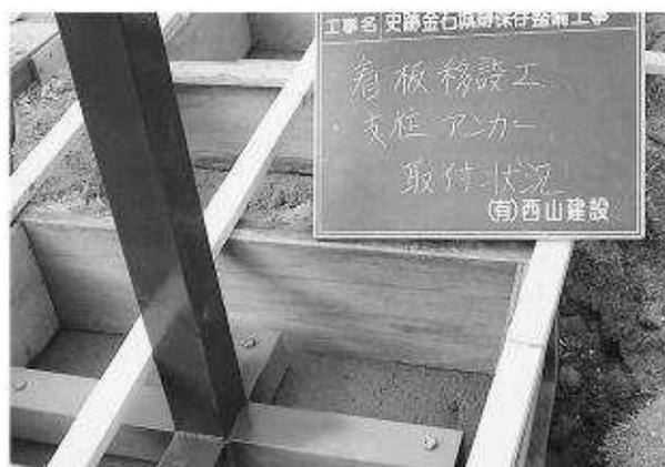
写真293 支柱アンカー取付状況
