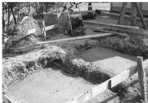
写真291 基礎碎石施工状況
