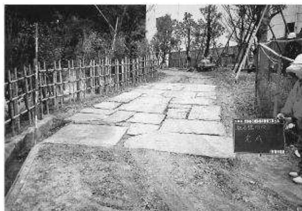
写真207 板石据付② 完了
