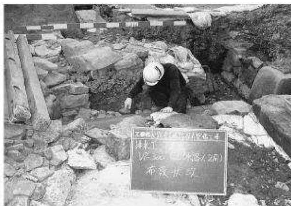
写真162 暗渠管B (VP300) 設置状況
