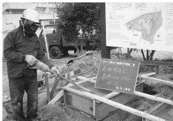
写真292 捨てコンクリート打設状況
