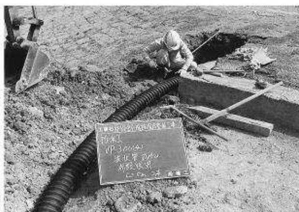
写真166 暗渠管D (φ150) 設置状況
