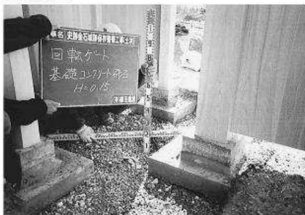
写真233 基礎砕石施工状況
