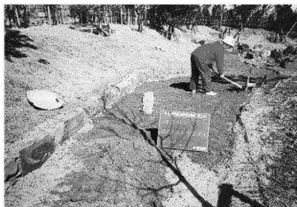
写真199 砂利数 基盤整正状況
