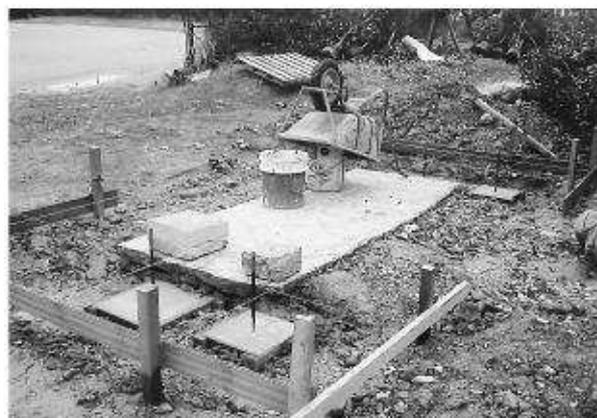
写真219 コンクリート基礎施工状況
