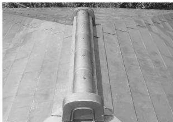
写真268 棟瓦 完了
