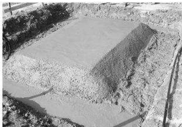
写真252 捨てコンクリート打設状況
