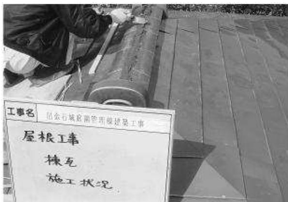
写真267 棟瓦施工状況
