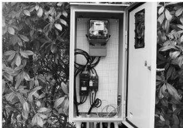
写真281 引き込み開閉器盤
