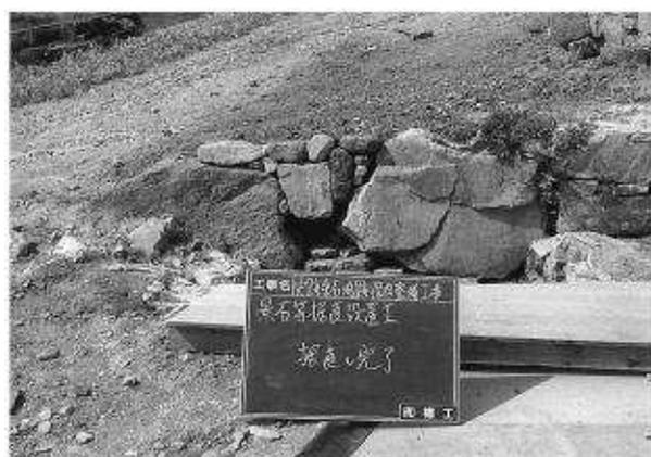
写真167 暗渠管D (φ150) 排水口状況
