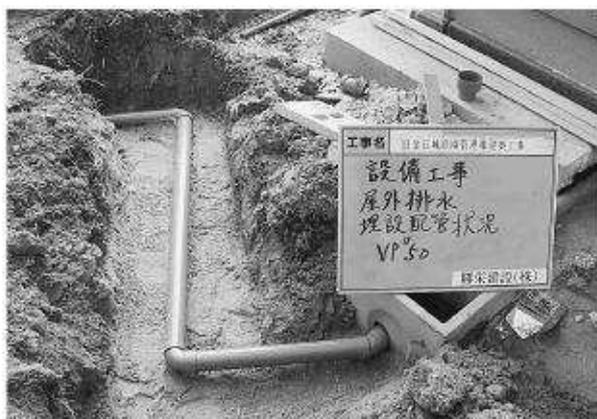
写真285 排水管設置状況
