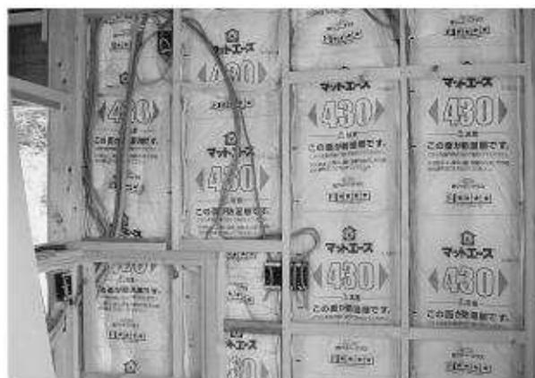
写真277 グラスウール施工状況
