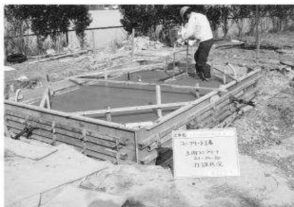
写真254 土間コンクリート打設状況
