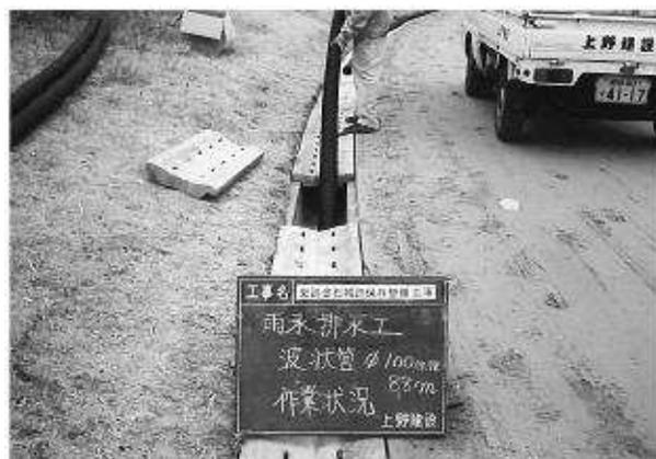
写真191 暗渠管φ100設置状況
