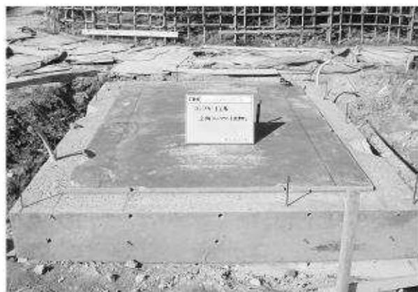
写真255 土間コンクリート打設完了
