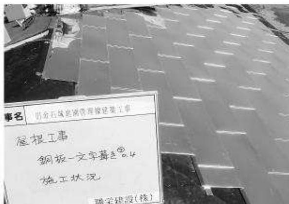
写真266 鋼板-文字葺き施工状況
