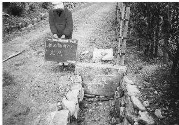
写真204 板石据付① 完了
