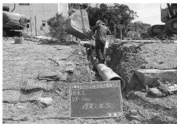
写真165 暗渠管C (VP300) 埋戻状況
