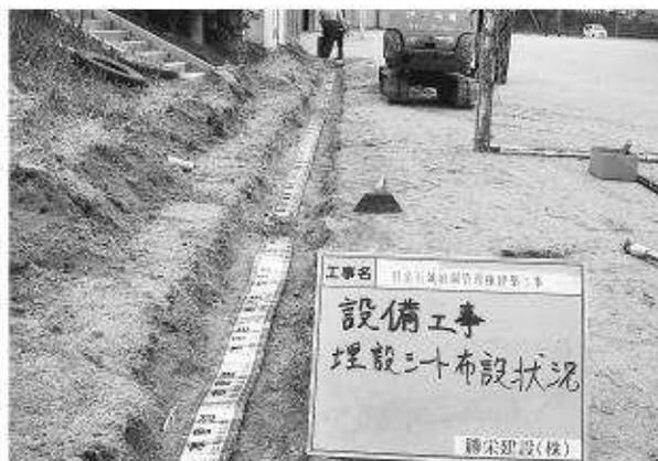
写真284 埋設シート布設状況
