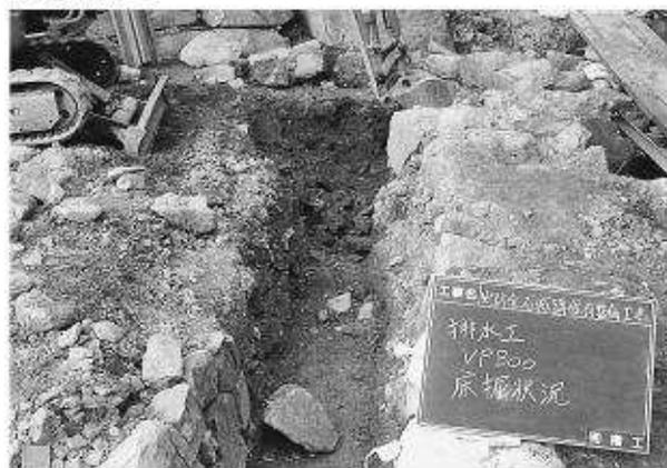
写真161 暗渠管B (VP300) 床掘状況
