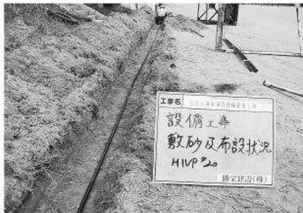
写真282 水道管布設状況
