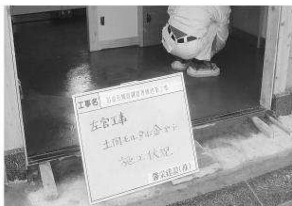
写真270 土間モルタル金ゴテ施工状況
