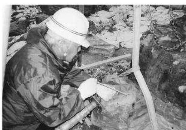
写真127 ステンレスアンカービン挿入状況
