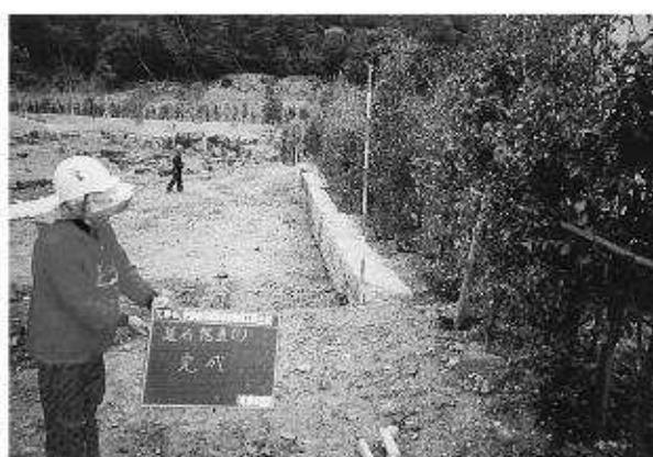
写真120 延石据え直し 完了
