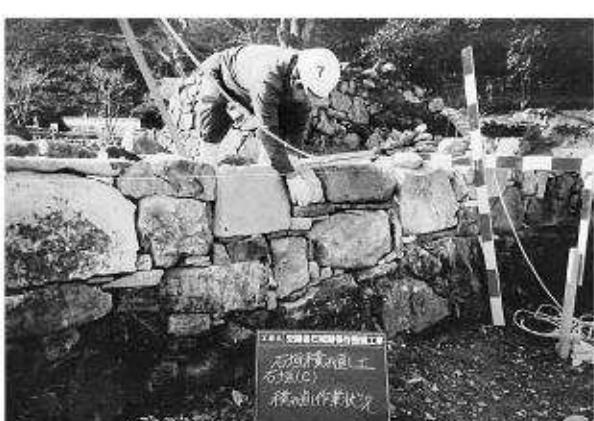
写真39 石垣C 石垣積み直し状況
