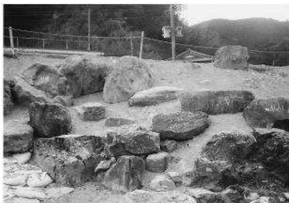
写真115 景石据え直し 完了
