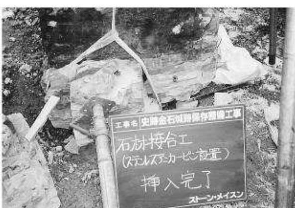
写真128 ステンレスアンカービン挿入完了
