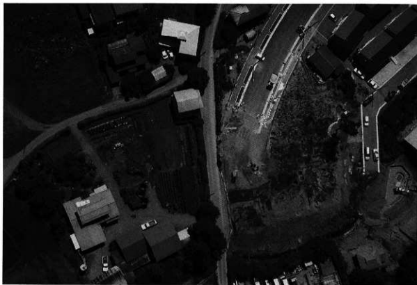
第18次調査区全景1 (図版上が南)
