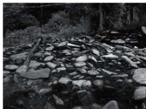
礫詰み方状況 (L=-0.7m)
