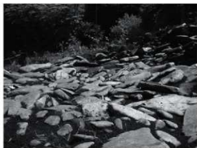
礫詰め方状況 (L=-0.9m)
