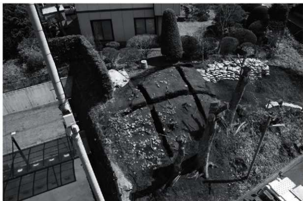
経塚全景（西から）
