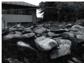
礫詰み方状況 (L=-0.6m)
