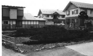
試掘調査状況
