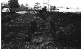
第8次 試掘調査状況
