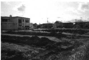
試掘調査状況
