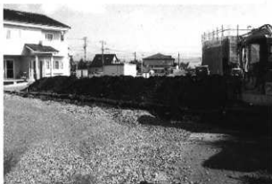
試掘調査状況
