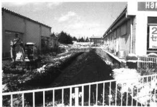
試掘調査状況
