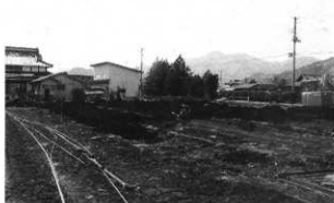
第9次 試掘調査状況
