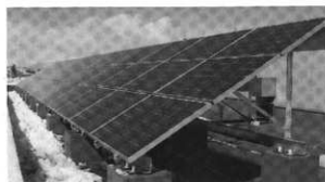
太陽光パネル設置状況(屋上)
