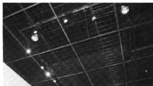
LEDライトの設置状況(企画展示室)
