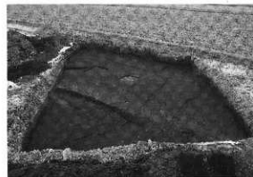
3区の試掘状況
