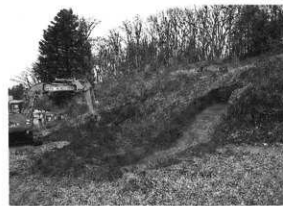
試掘調査状況
