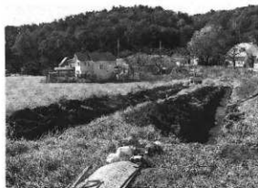
試掘調査状況
