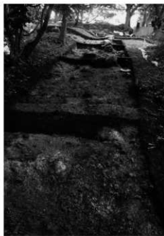
5. 道路跡 検出状況(北東から)
