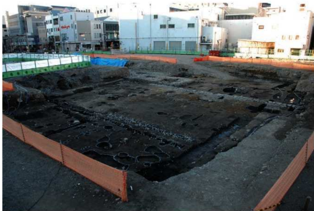
A区Ⅱ検全景（南東から）
