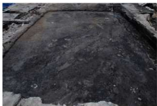
A区V検全景 (南から)
