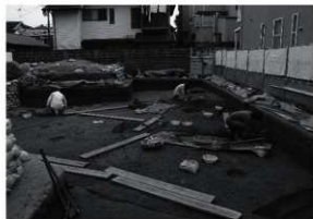
図30 作業風景（北から）
