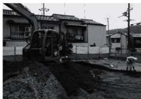
図24 作業風景 (北北東から)
