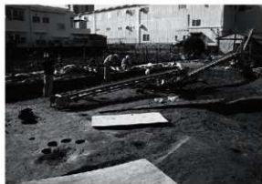
図76 作業風景（北から）
