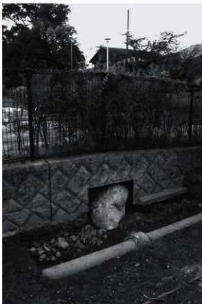
2 3区大仏台座（南東から）
