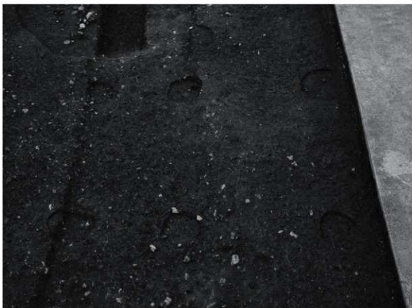
2 建物1全景（北から）
