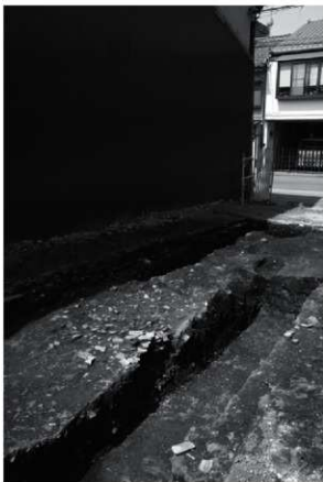
2 SD4 検出状況、SX1 築地基底断面（北東から）
