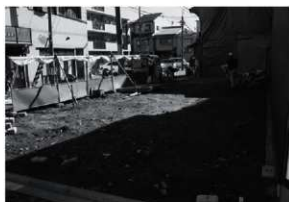
図3 調査前全景 (南西から)
