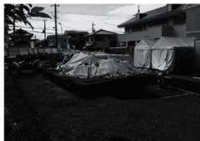
図4 作業風景（北東から）
