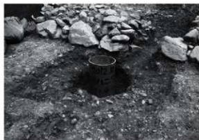
図10 1トレンチ埋戻し後、塩ビ管設置状況（北西から）
