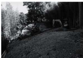
図5 2トレンチ重機掘削（南から）
