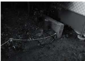
図8 「塚」1北東隅土留め状況(北東から)
