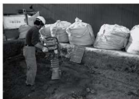
図6 埋め戻し状況
