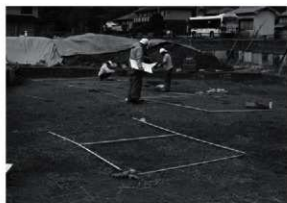
図3 作業風景 (東から)
