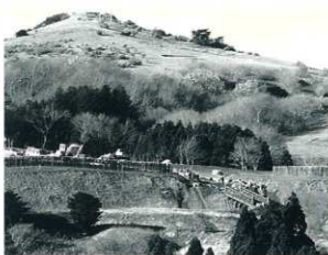
1 木橋・柵整備工事
