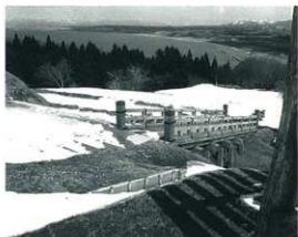
4 木橋整備状況
