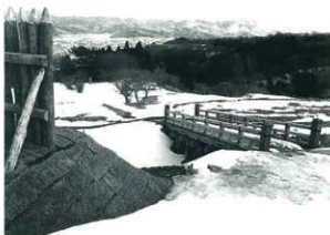
5 柵、木橋整備状況
