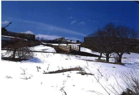
1 木橋・柵整備 (後方夷王山)
