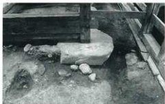
2 トオリニワ入口付近礎石掘えつけ —掘り方（東から）
