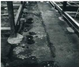
1 トオリニワ下層：旧笹浪家前身遺構柱列 手前白色部分は1640年降灰Ko-d火山灰 (南から)
