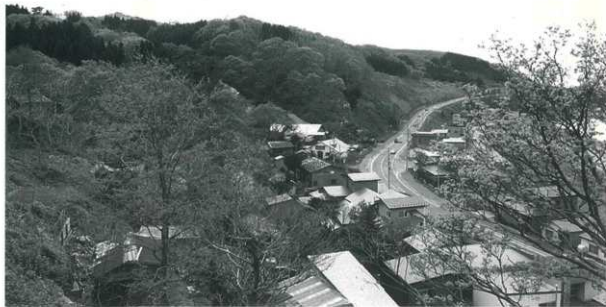
1 調査区遠景 (東から)
