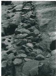
5 溝26上部集石列 (北西から)
