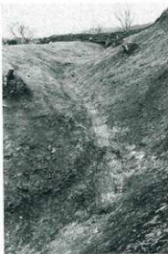
空壕A（西より）
