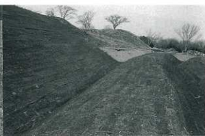
空墳跡張芝法面保護（南から）
