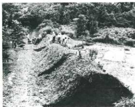
作業風景 1 (土堤部)
