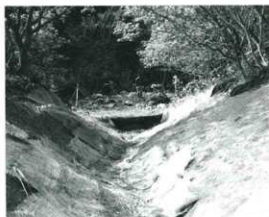
壇跡部作業風景 2
