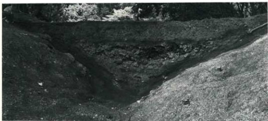
1 空堀内土層堆積状況—調査区北西端、南東より—
