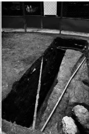
2 4区掘込地業検出状況（北西から）
