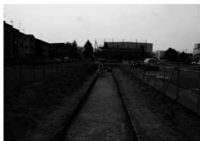
图104 2区作業風景 (北から)
