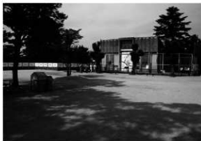
図4 調査前全景1・2区(北東から)
