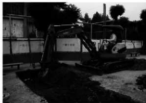
図5 重機掘削
