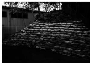
図68 現存土塁保護状況
