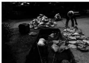
図9 3区埋め戻し状況
