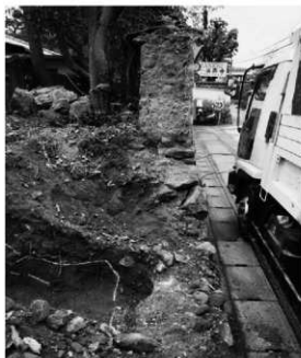
写真 18 1Tr 西端及び土塀断面（北から）
