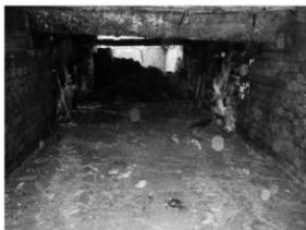
写真8 水路6内部（東から）
