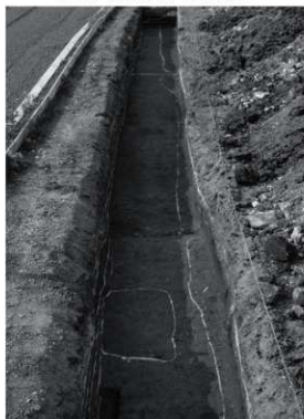
写真29 A2区全景(南から)
