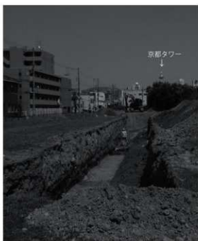
写真7 D2～D4区全景(西から)
