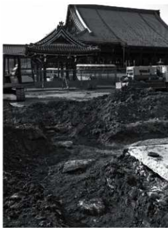
写真11 1区・2区検出礎石列(東から)
