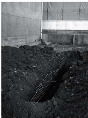
写真14 No.58地点2Tr全景(南東から)
