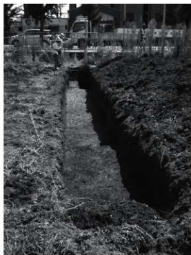
写真19 トレンチ全景（北から）
