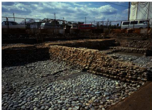
第79次調査 建物1掘込地業（北東から）
