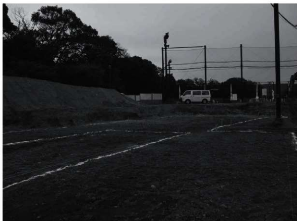
1 No.1 地点全景 (南西から)
