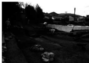
図3 作業風景 (南東から)
