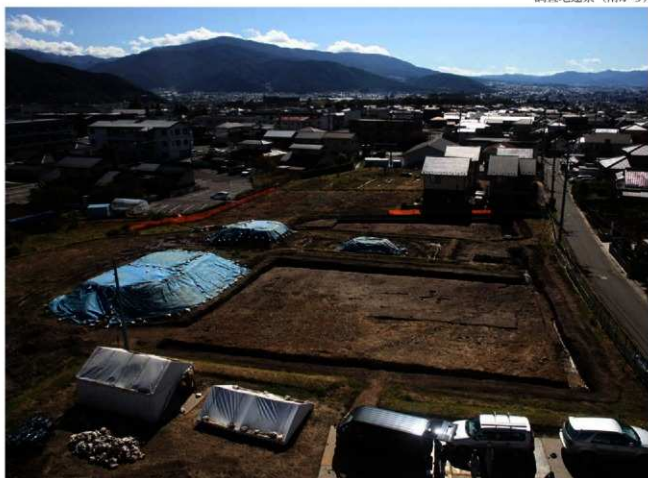
調査地遠景（北西から）
