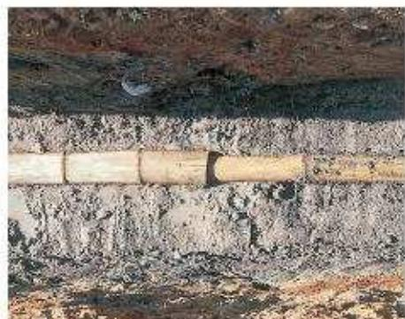
竹製給水管の継手部分
