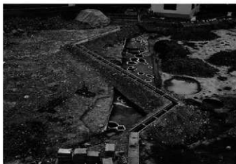
水路下完掘 北から
