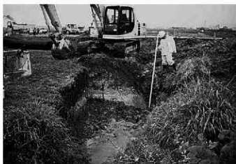
町道工事立会い 東から
