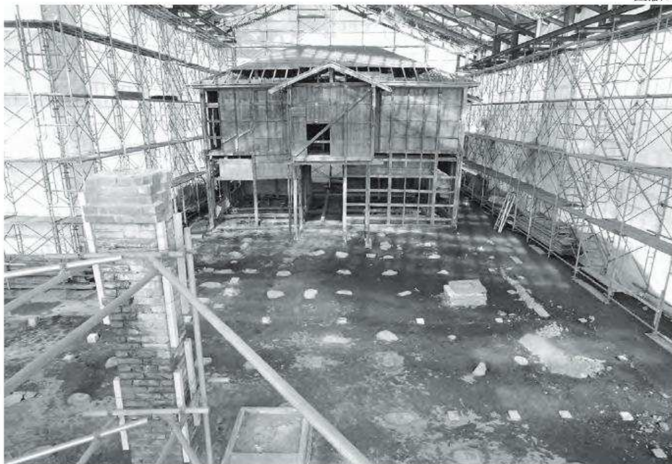
1. 調査前の状況(北棟ジャッキアップ前・南から)
