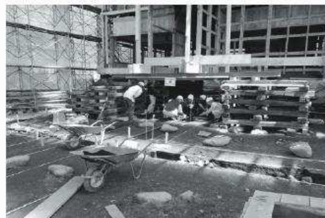
7. 調査風景北棟(南から)
