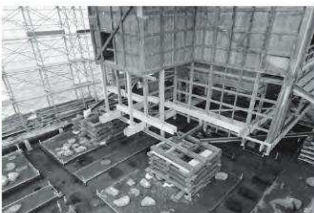
8. 北棟・中央棟調査状況(東から)
