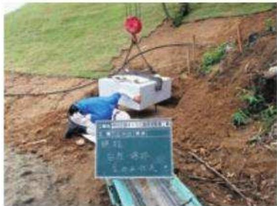
Fig.150 標識台座の設置
