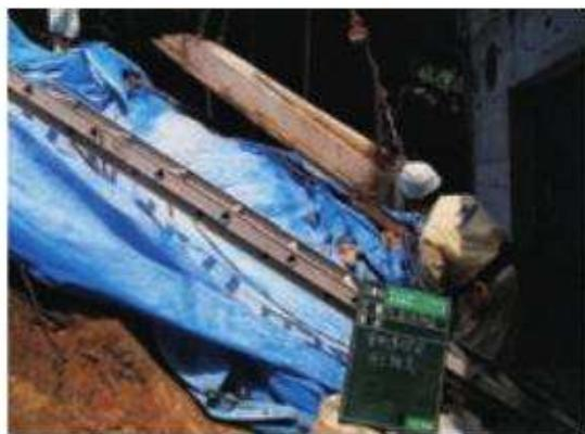
Fig.51 東側基礎吊り上げ撤去
