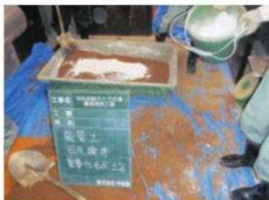
Fig.33 消石灰混合作業
