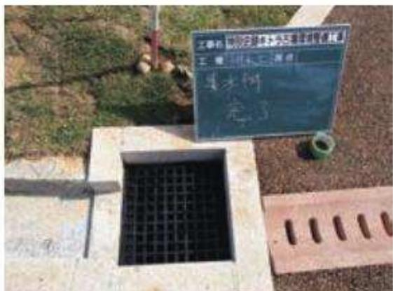
Fig.132 集水樹 施工完了
