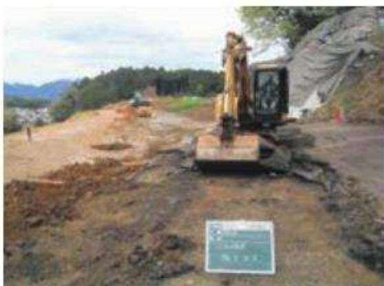
Fig.76 アスファルト舗装撤去状況
