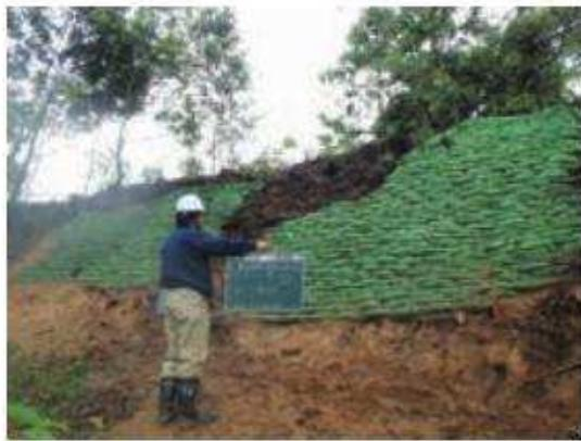
Fig.120 北側斜面東寄り 植生土のう積み完了
