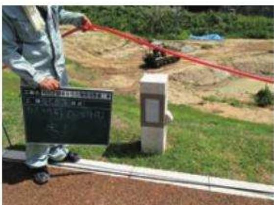
Fig.178 照明灯防水コンセント付
