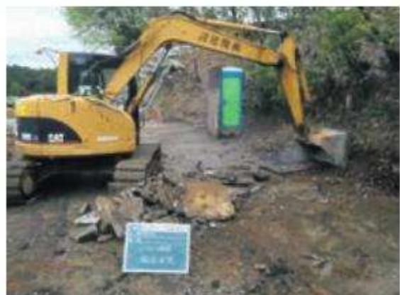
Fig.77 コンクリート舗装撤去状況
