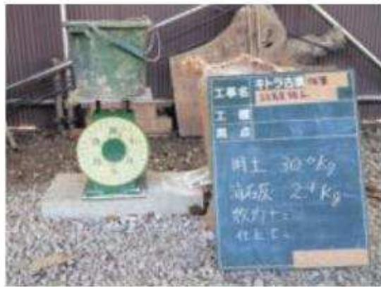
Fig.28 試験施工での材料の配合②
