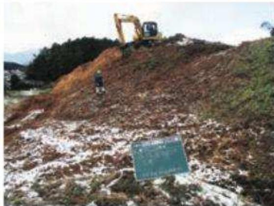
Fig.68 南西部竹伐根施工状況
