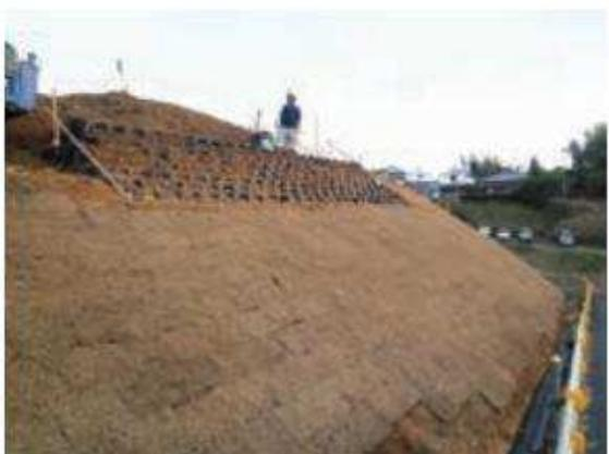
Fig.110 補強土壁表面の張芝（園路西斜面）
