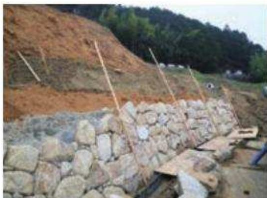
Fig. 124 石積擁壁施工状況
