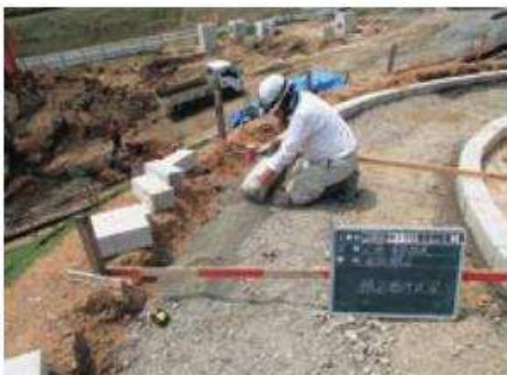
Fig. 186 圖路緣石設置狀況
