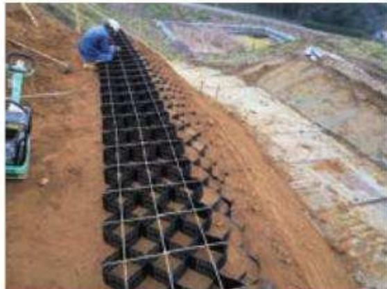
Fig.109 補強土壁施工状況（園路西斜面）②
