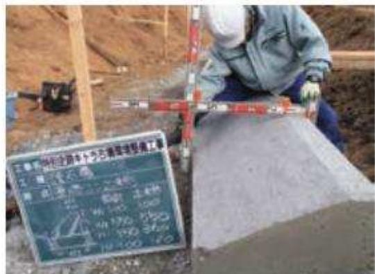
Fig.123 石積擁壁コンクリート基礎
