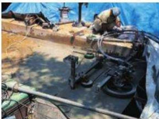
Fig.48 突起梁部分 ワイヤーソーでの水平切断状況
