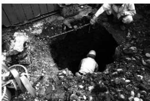
塚越貝塚工事立会
