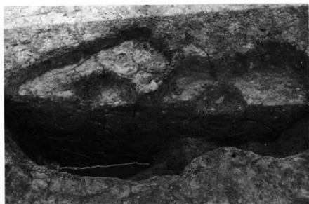
寄柱 掘り方断面
