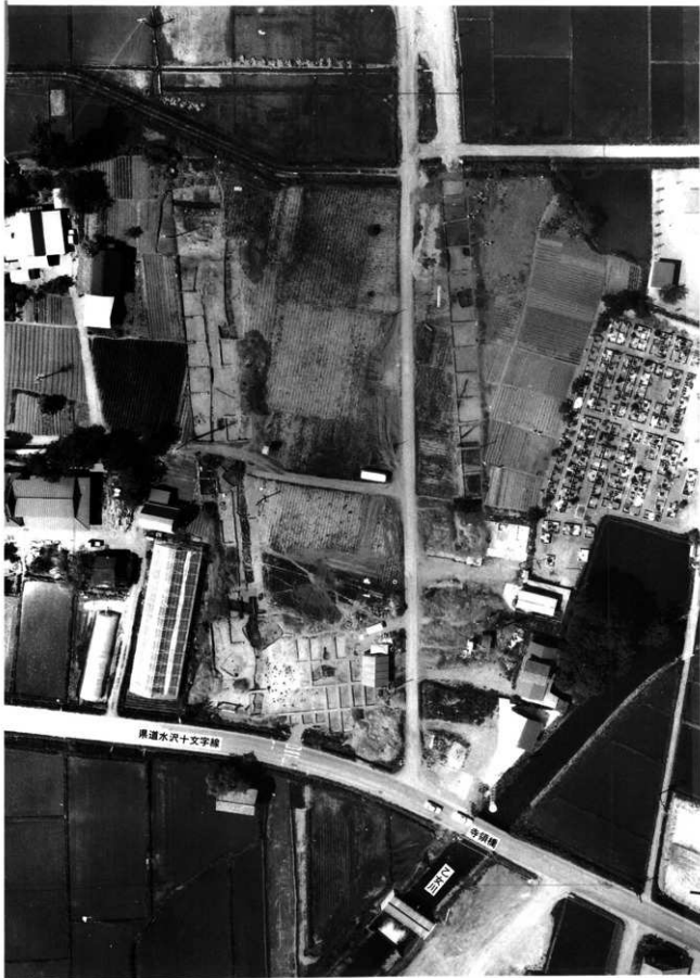
写真図版1 水沢 石田遺跡全景航空写真
