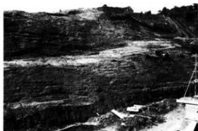
調査地北側第三・第四平場
