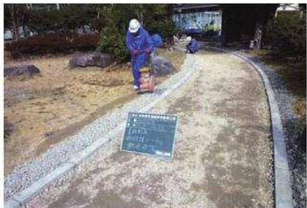
写真70 園路工素掘側溝碎石転圧状況 (No.0～11)
