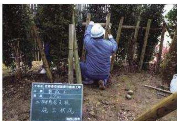
写真78 植栽工植栽二脚鳥居支柱施工状況
