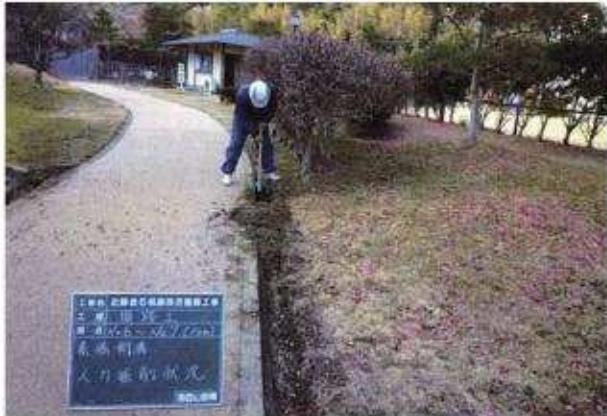
写真65 園路工素掘側溝床掘状況 (No.6～7)
