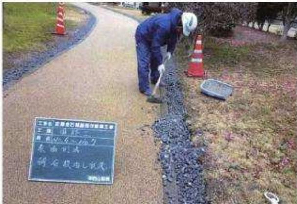
写真67 園路工素掘側溝碎石充填敷均し状況 (No.6～7)
