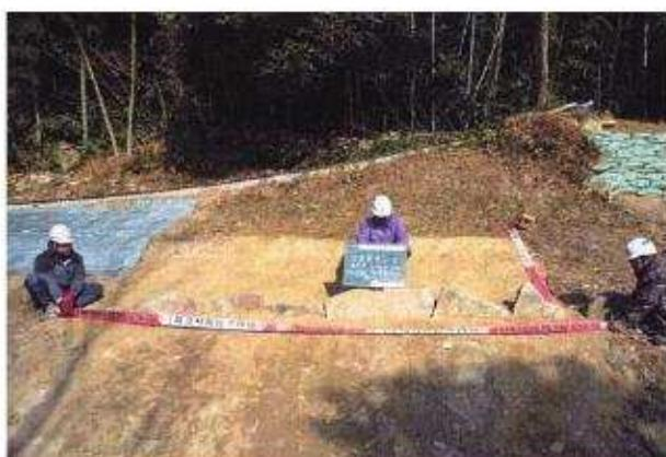
写真 5 法面復旧工法面整形 (B) 出来形
