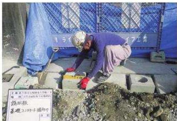
写真100 説明板基礎コンクリート据付
