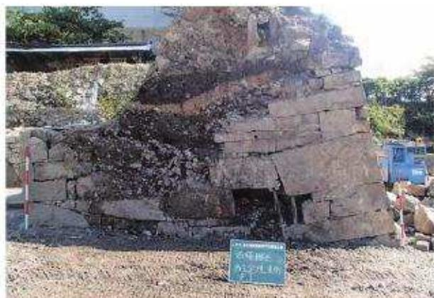
写真142 石積み（門閉塞部）撤去完了状況 2
