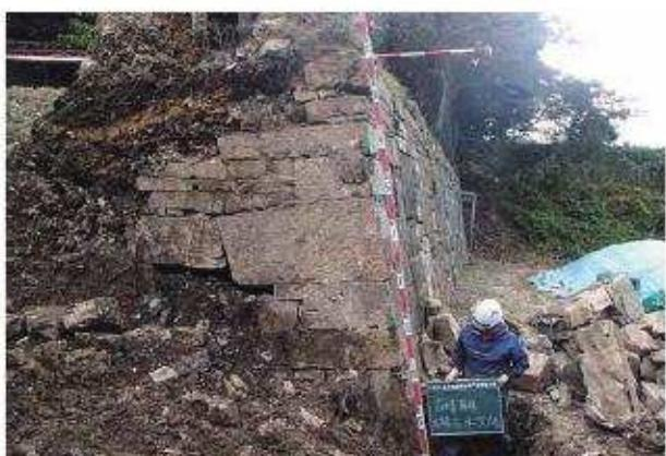
写真136 石積み（門閉塞部）解体状況4
