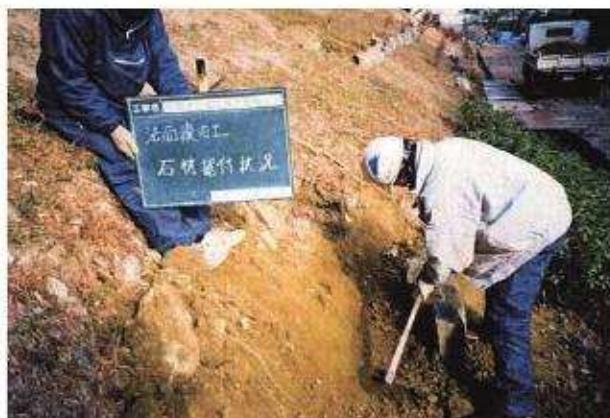
写真 4 法面復旧工石材据付状況 (C)
