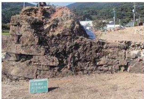
写真143 石積み（門閉塞部）撤去完了状況 3
