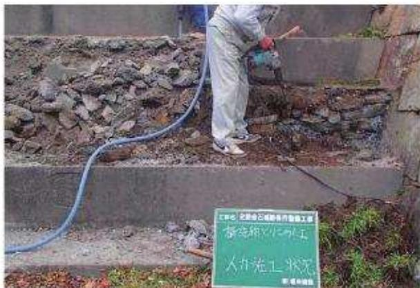
写真83 撤去工構造物取壊し工人力施工状況
