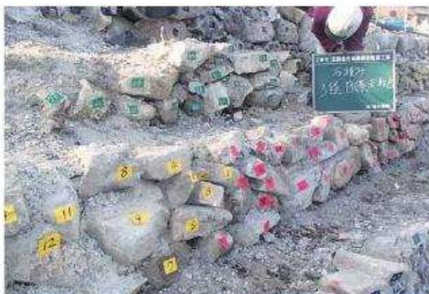
写真85 石段修理工石段番号付け (上部から3段目)
