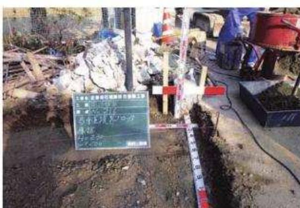
写真56 園路工園路舗装入口部歩車道境界ブロック床掘出来形
