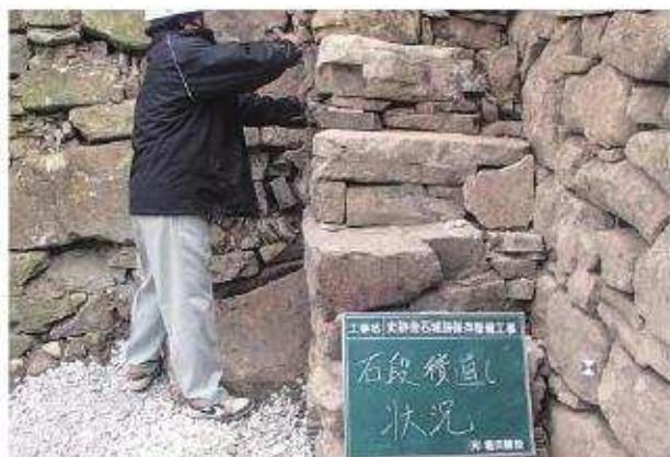
写真94 石段修理工石段据直し
