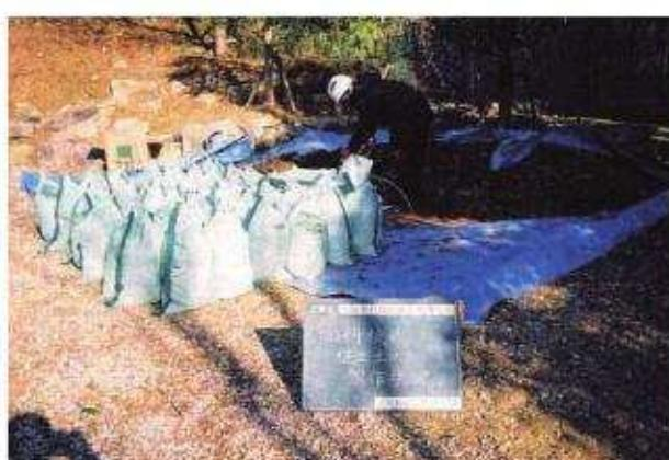
写真 8 法面復旧工植生土のう製作状況 (A)
