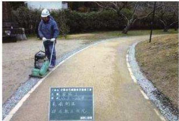
写真68 園路工素掘側溝碎石転圧状況 (No.3～4)
