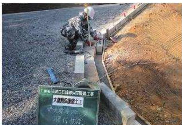
写真125 大階段地先ブロック据付状況
