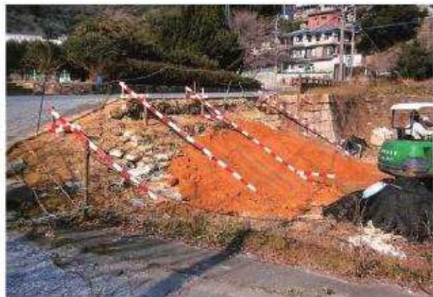
写真122 大階段盛り土施工状況
