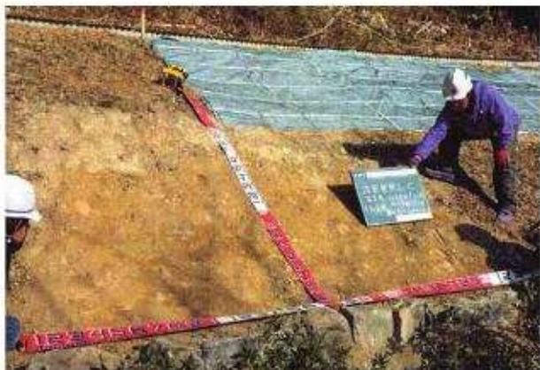
写真12 法面復旧工法面整形 (C) 出来形
