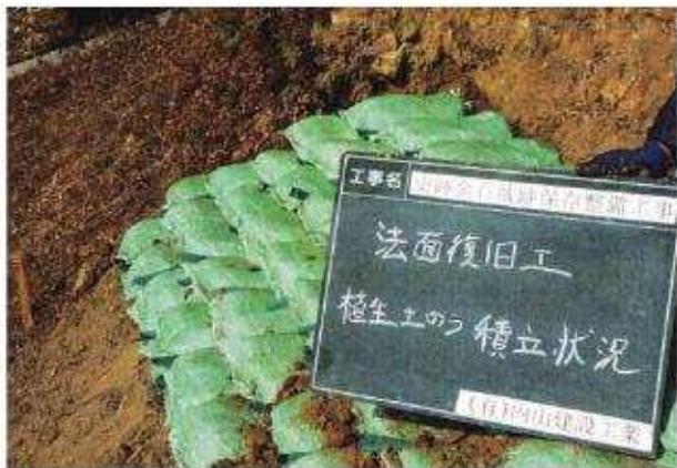
写真10 法面復旧工植生土のう積立状況 (A)
