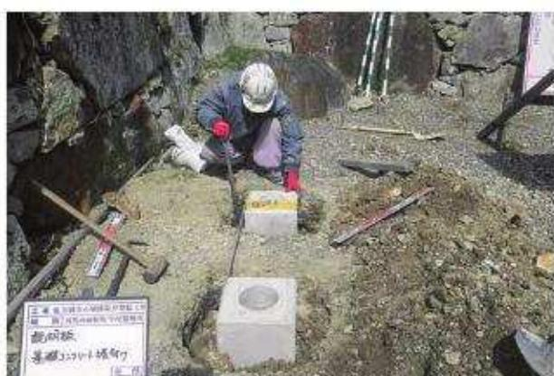
写真104 説明板基礎コンクリート据付
