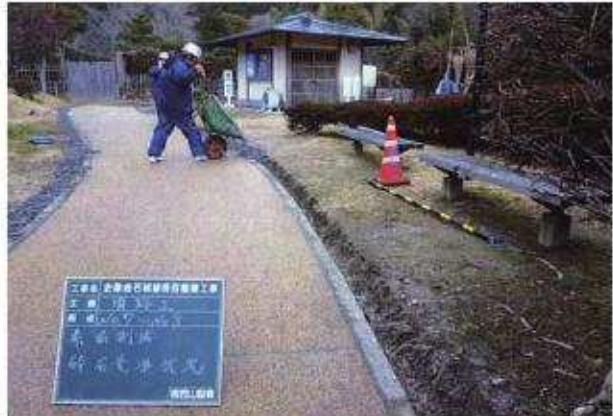
写真66 園路工素掘側溝碎石充填状況 (No.7～8)
