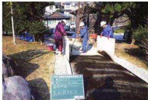
写真60 園路工園路舗装アスファルト舗装プライムコート (No. 0 ~21・6)
