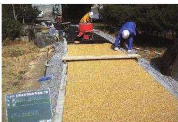
写真63 園路工園路舗装天然石透水性舗装施工状況 (No. 0 ~21・6)
