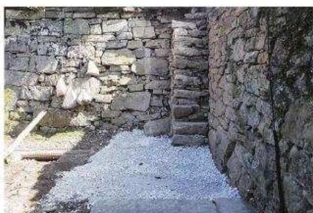
写真96 石段修理工石垣解体・土のう積工
