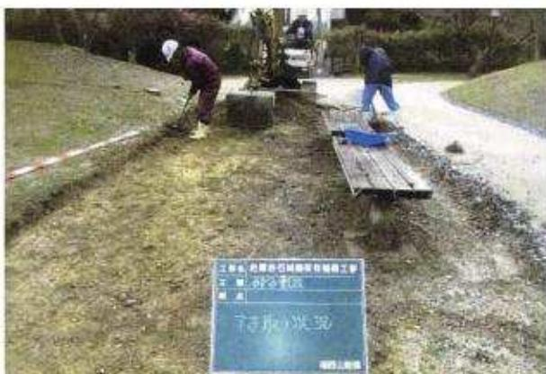
写真71 園路工碎石舗装掘削状況
