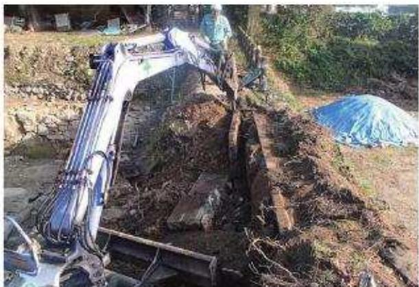
写真132 構造物取り壊し工埋設側溝撤去状況3
