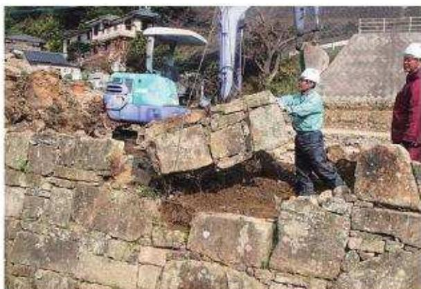
写真133 石積み（門閉塞部）解体状況1
