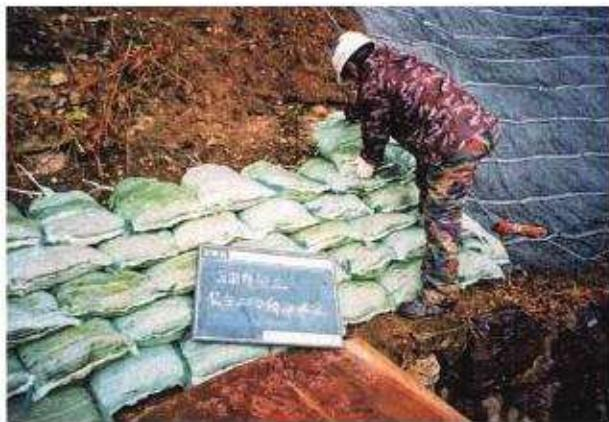
写真9 法面復旧工植生土のう積立状況 (D)
