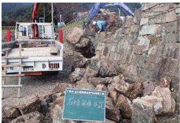
写真134 石積み（門閉塞部）解体状況2
