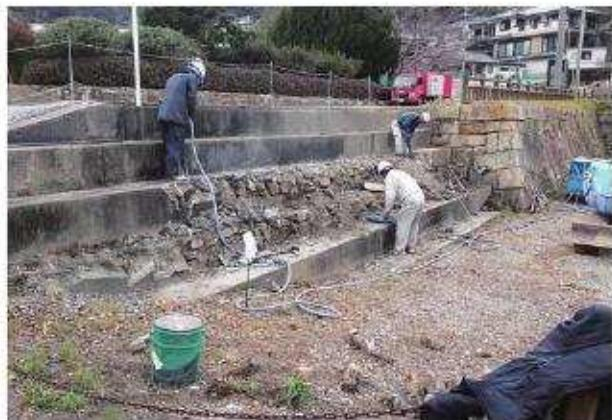
写真82 撤去工構造物取壊し工人力施工状況
