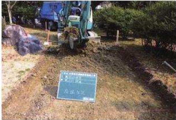
写真57 園路工園路舗装床掘状況 (No. 0 ~21・6)
