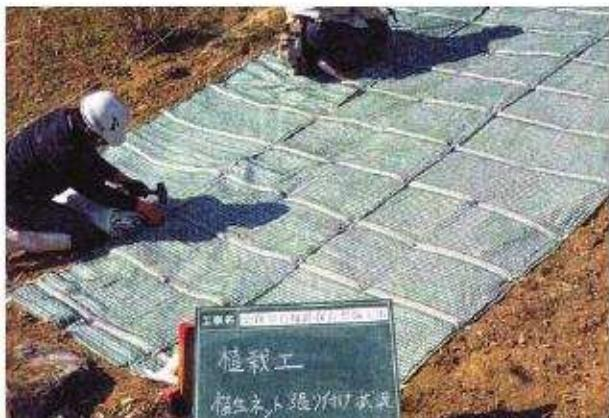
写真11 植栽工植生ネット工施工状況
