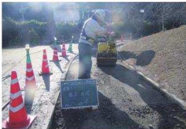
写真33 極端材転圧状況 (No. 2 ~ 4)
