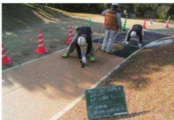
写真39 玉砂利敷均しコテ仕上げ状況 (No. 0 ~ 2)
