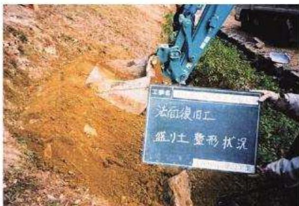
写真 3 法面復旧工盛土法面整形状況 (C)
