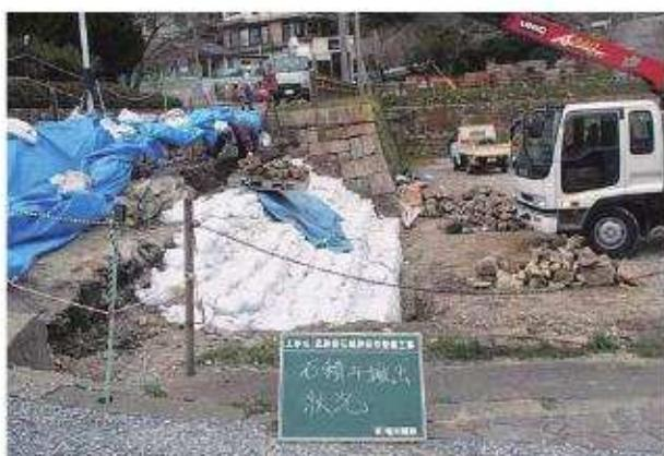
写真87 石段修理工石段解体・土のう積工
