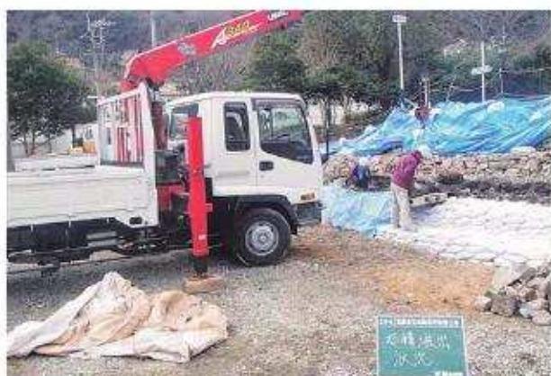
写真88 石段修理工石段解体・土のう積工
