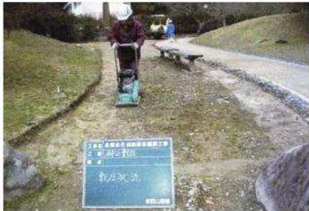
写真73 園路工碎石舗装路床転圧状況
