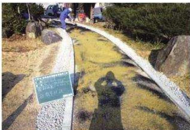
写真61 園路工園路舗装アスファルト舗装砂散布状況 (No. 0 ~21・6)
