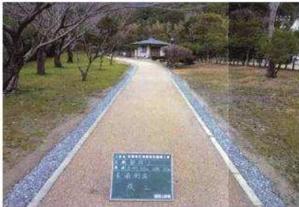
写真50 園路工素掘側溝竣工
