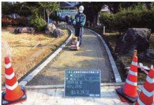
写真59 園路工園路舗装路盤転圧状況 (No. 0 ~11)
