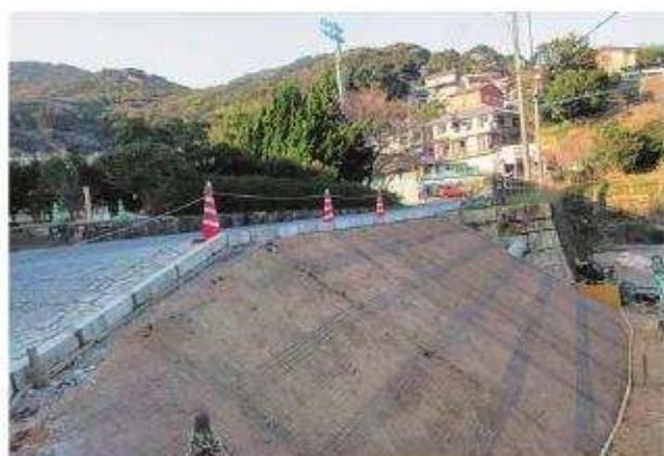
写真126 大階段溶接金網敷き込み完了状況
