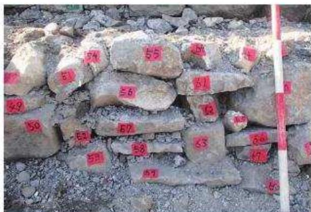
写真86 石段修理工石段番号付け (上部から3段目)
