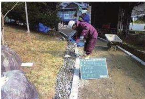
写真69 園路工素掘側溝碎石充填敷均し状況 (No.11～21・6)
