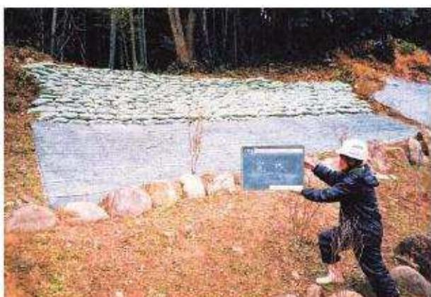
写真13 法面復旧工植生土のう積立完了 (A)
