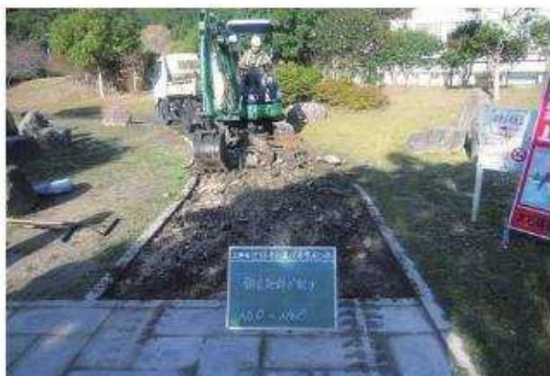
写真29 補装版剥取状況 (No. 0 ~ 2)
