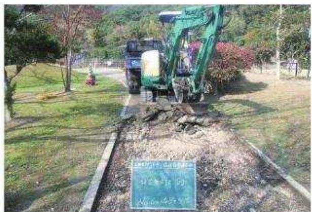
写真30 補装版剥取状況 (No. 6 ~ 8)
