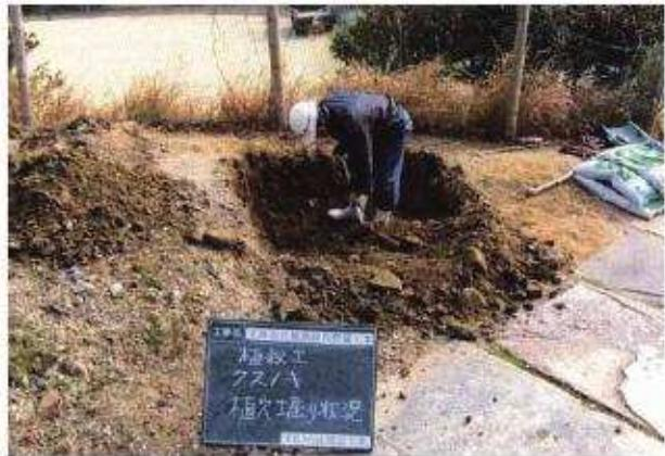
写真18 植栽工クスノキ植穴掘削状況
