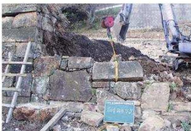
写真135 石積み（門閉塞部）解体状況3
