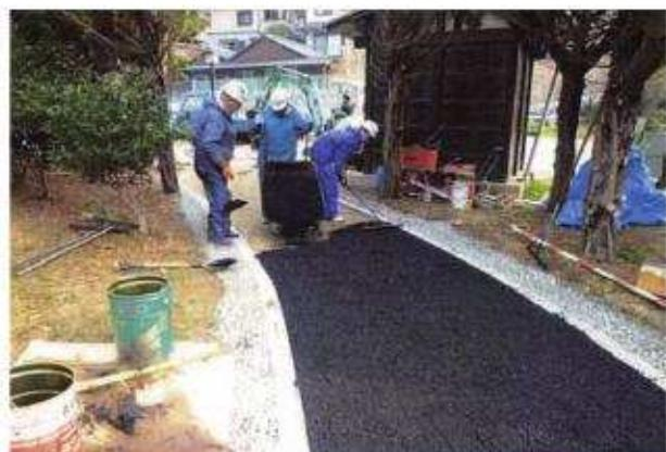
写真62 園路工園路舗装アスファルト舗装合材人力敷均し状況 (No. 0 ~21・6)
