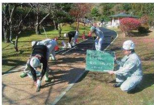
写真40 玉砂利敷均しコテ仕上げ状況 (No. 4 ~ 6)
