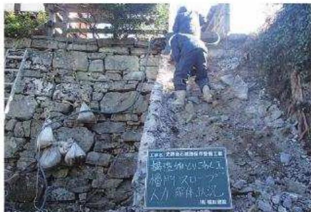
写真92 撤去工構造物取り壊し工人力施工状況
