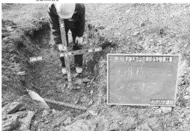
写真425 平成26年度整備工事学習施設工説明板床掘状況
