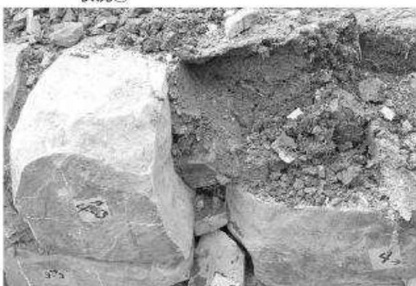
写真108 平成19年度石室修理工 2号墳羨道西側壁解体
