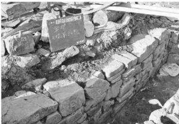
写真78 平成19年度石室修理工 2号墳奥壁積み直し状況⑦
