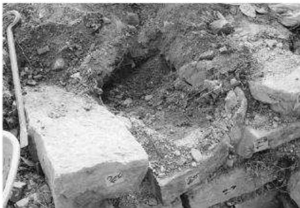
写真101 平成19年度石室修理工 2号墳羨道西側壁解体
