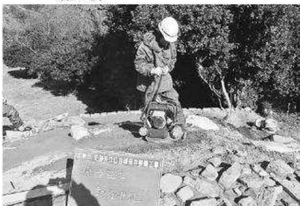
写真393 平成25年度墳丘整備工墳丘盛土盛土転圧状況（西から）
