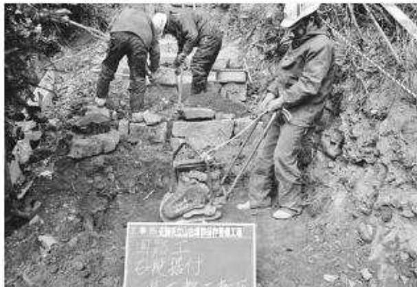
写真434 平成26年度整備工事園路工石段据付基面整転圧状況
