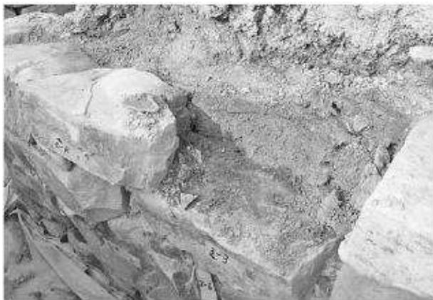
写真149 平成19年度石室修理工 2号墳羨道東側壁解体
