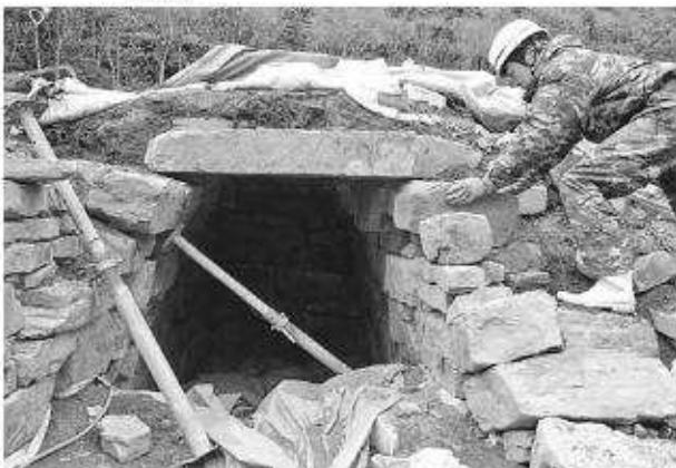
写真388 平成25年度墳丘整備工石室修理施工状況
