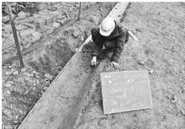
写真238 平成22年度雨水排水工素掘側溝土舗装状況
