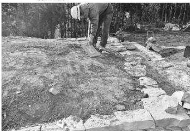
写真394 平成25年度墳丘整備工墳頂部復元盛土転圧状況（北から）
