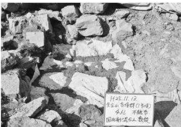
写真334 平成25年度 1号墳整備作業 4トレンチ東不織布及び固化剤混合土敷設状況
