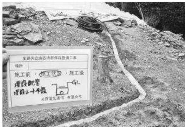
写真280 平成24年度照明施設工事埋設シート敷設状況①(南西から)
