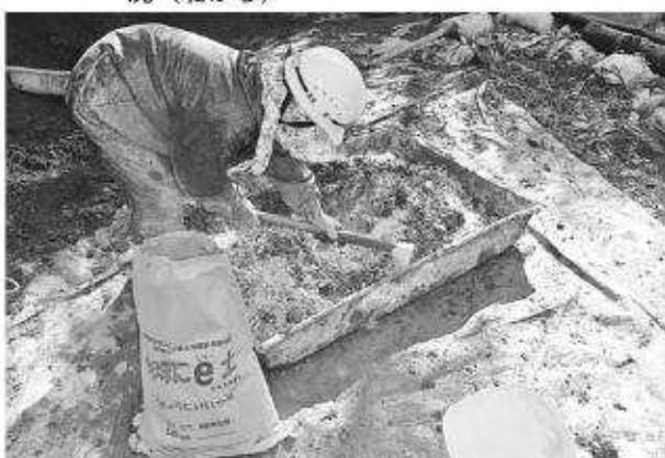
写真396 平成25年度墳丘整備工土舗装固化剤練り混ぜ状況
