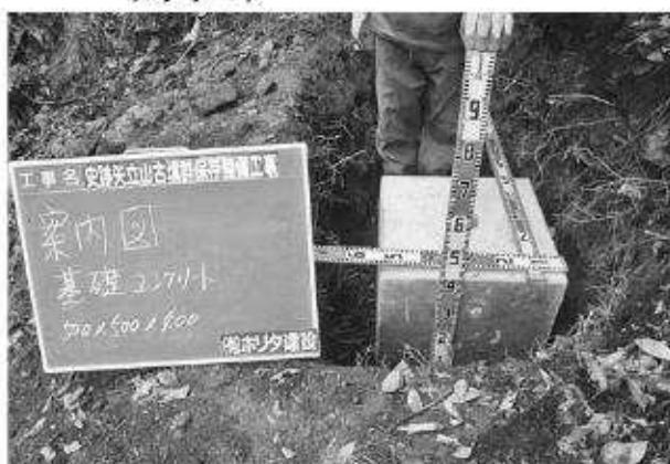
写真428 平成26年度整備工事学習施設工案内図基礎コンクリート
