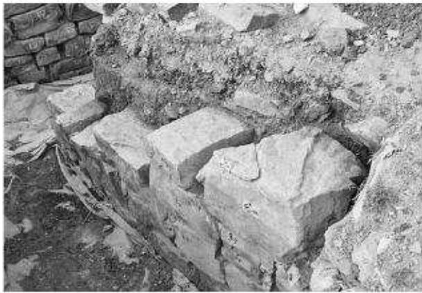
写真151 平成19年度石室修理工 2号墳羨道東側壁解体
