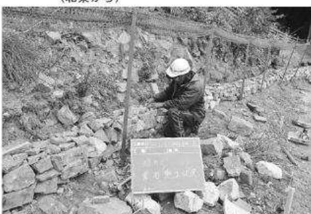
写真236 平成22年度雨水排水工蛇籠設置状況（南から）
