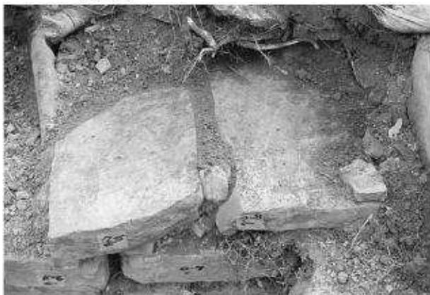
写真103 平成19年度石室修理工 2号墳羨道西側壁解体
