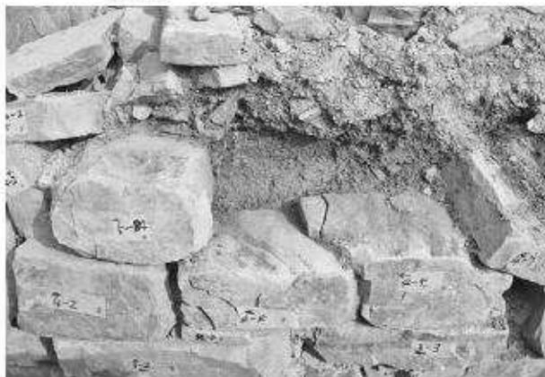
写真144 平成19年度石室修理工 2号墳羨道東側壁解体
