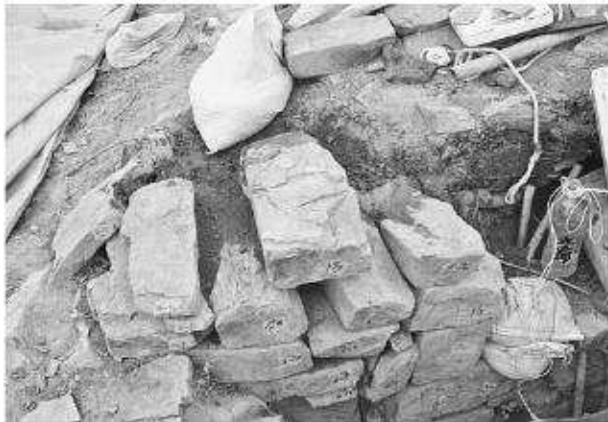
写真123 平成19年度石室修理工 2号墳羨道西側壁積み
