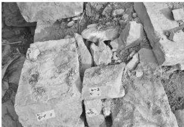
写真145 平成19年度石室修理工 2号墳羨道東側壁解体
