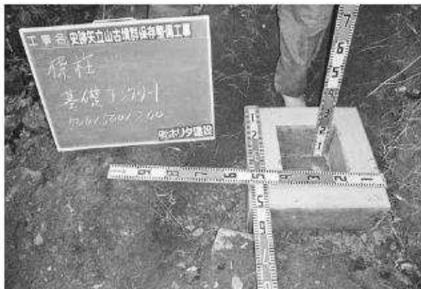
写真430 平成26年度整備工事學習施設工標柱基礎コンクリート
