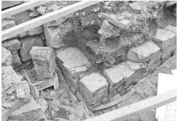
写真159 平成19年度石室修理工 2号埴道東側壁解体
