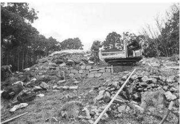
写真378 平成25年度墳丘整備工土留石積施工状況（東から）
