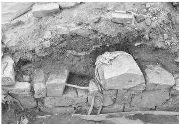
写真118 平成19年度石室修理工 2号墳羨道西側壁解体
