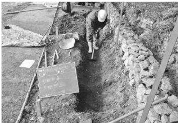
写真237 平成22年度雨水排水工素掘側溝不陸整正状況
