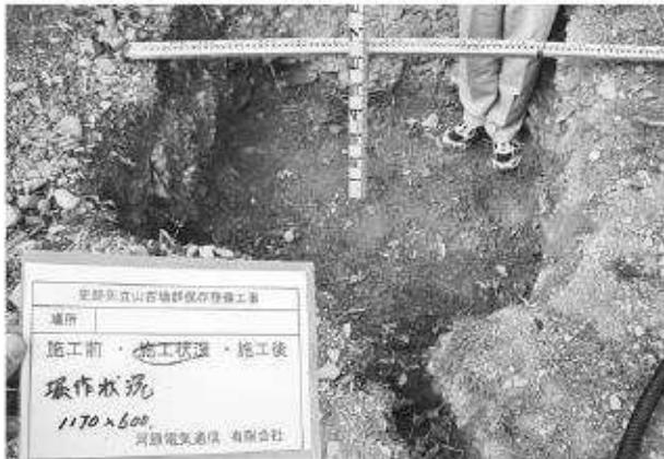
写真267 平成24年度 照明施設工ソーラー設備基礎掘削状況
