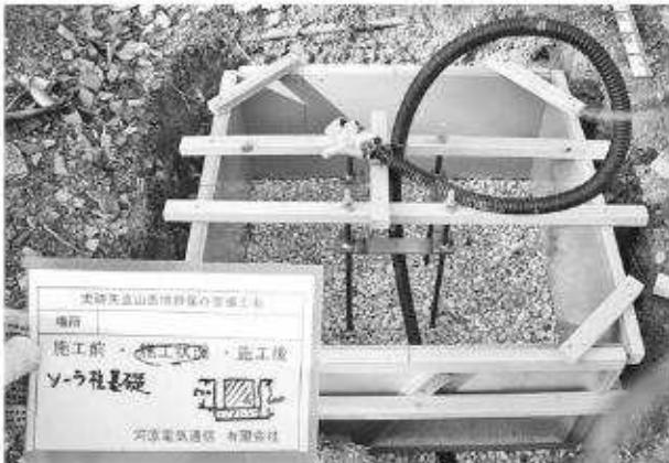
写真268 平成24年度 照明施設工ソーラー設備基礎コンクリート施工状況①
