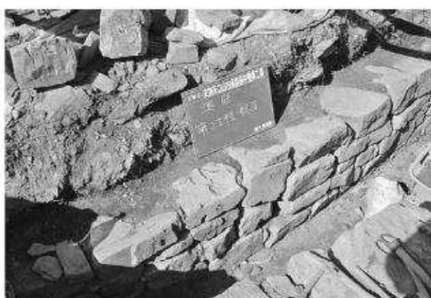
写真76 平成19年度石室修理工 2号墳奥壁積み直し状況⑤
