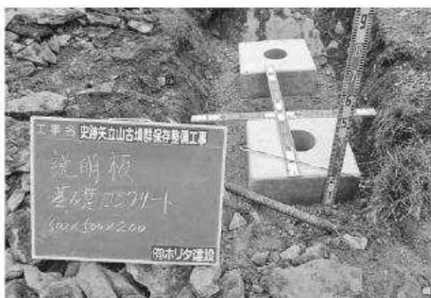
写真426 平成26年度整備工事学習施設工説明板基礎コンクリート
