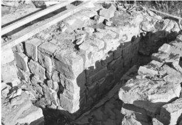
写真162 平成19年度石室修理工 2号埴道東側壁積み
