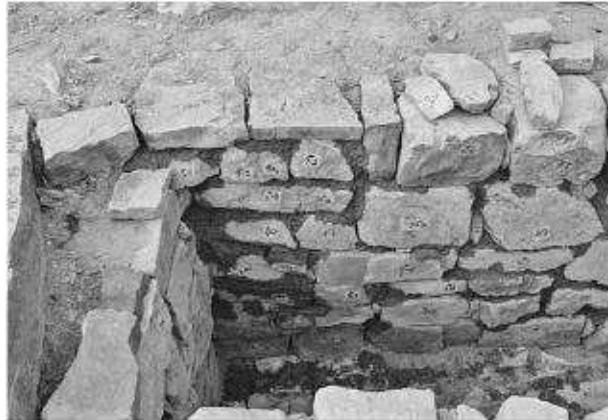
写真89 平成19年度石室修理工 2号墳奥壁西側積み直し完了状況
