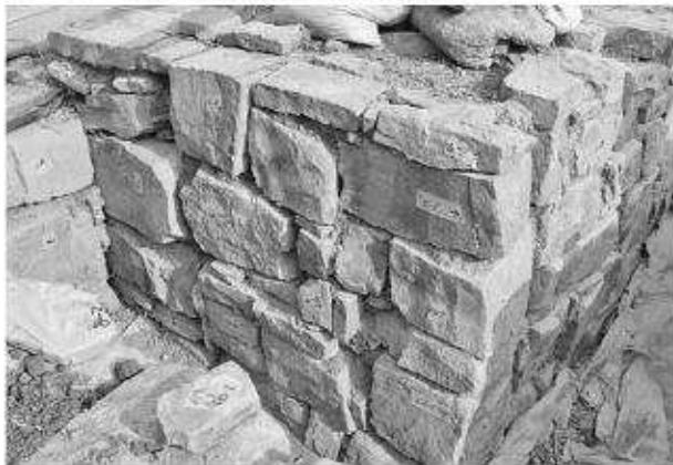
写真167 平成19年度石室修理工 2号墳東前壁積み直し完了状況①（西から）
