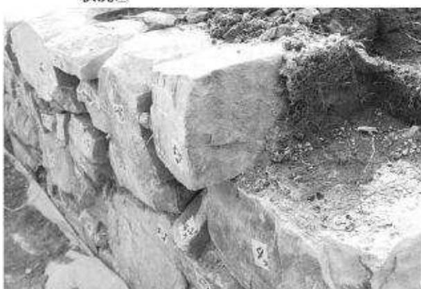
写真107 平成19年度石室修理工 2号墳羨道西側壁解体
