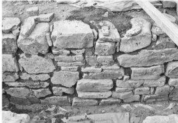
写真90 平成19年度石室修理工 2号墳奥壁積中央積み直し完了状況
