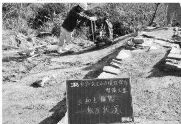
写真188 平成20年度 2号墳墳丘整備工三和土舗装転圧状況（北西から）
