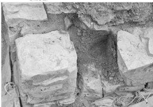
写真156 平成19年度石室修理工 2号墳羨道東側壁解体
