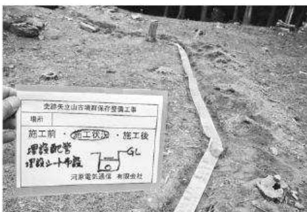
写真281 平成24年度照明施設工事埋設シート敷設状況②(西から)
