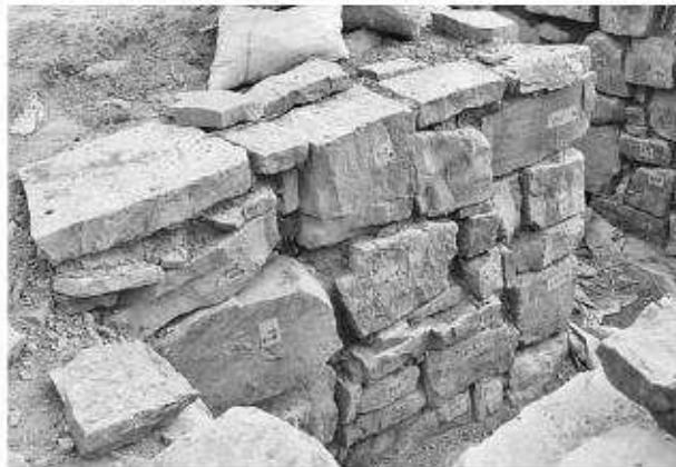
写真168 平成19年度石室修理工 2号墳東前壁積み直し完了状況②（北から）
