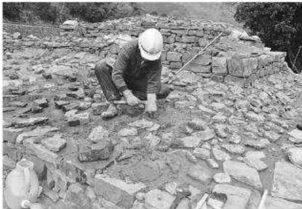
写真397 平成25年度墳丘整備工断面復元疊敷き及び目地詰め状況（南西から）
