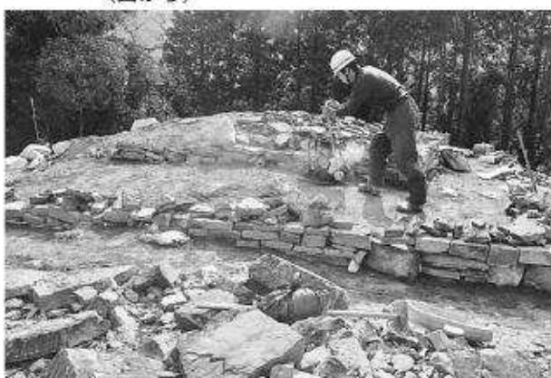
写真395 平成25年度墳丘整備工墳頂部復元盛土転圧状況（北から）
