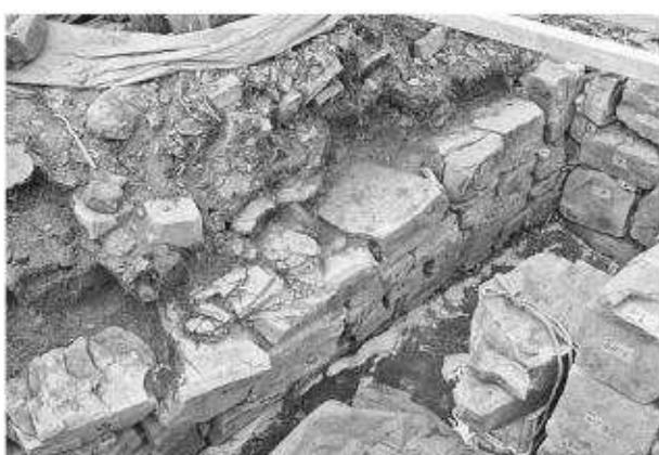
写真59 平成19年度石室修理工 2号墳奥壁解体状況⑤
