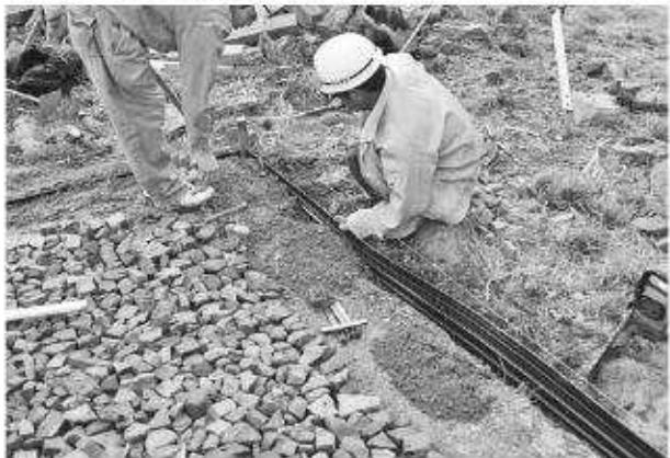
写真191 平成20年度 2号墳墳丘整備工根切り板敷設状況（北東から）
