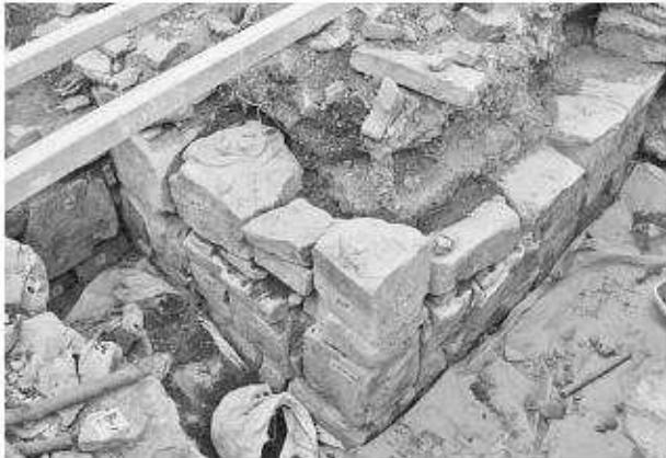
写真160 平成19年度石室修理工 2号埴道東側壁積み
