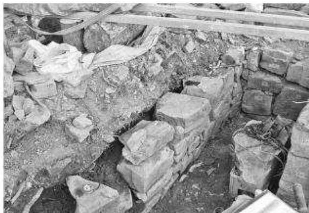
写真72 平成19年度石室修理工 2号墳奥壁積み直し状況①
