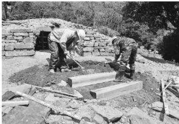
写真402 平成25年度墳丘整備工遺構保護工枕木階段設置状況（南西から）
