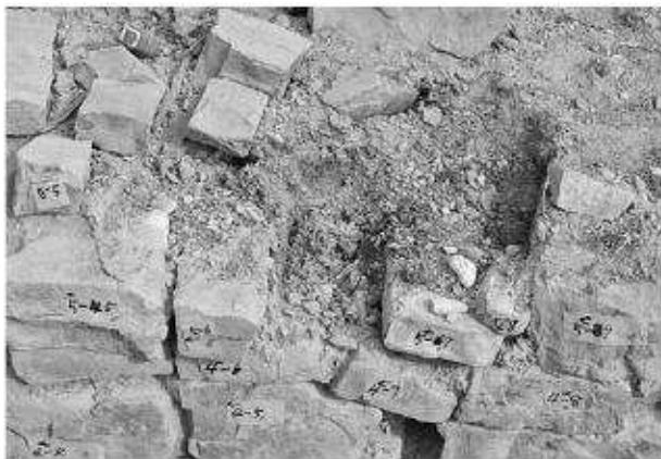
写真141 平成19年度石室修理工 2号墳羨道東側壁解体
