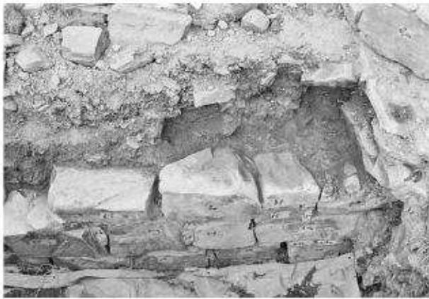
写真152 平成19年度石室修理工 2号墳羨道東側壁解体
