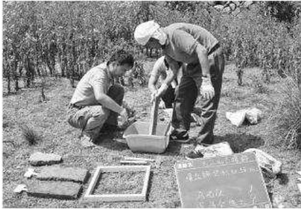
写真217 平成21年9月7日実施墳丘舗装材試験片作成
