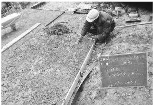
写真231 平成22年度園路広場工土舗装施工状況（北東から）
