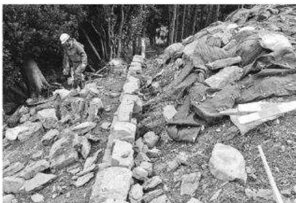
写真377 平成25年度墳丘整備工土留石積施工状況（北から）
