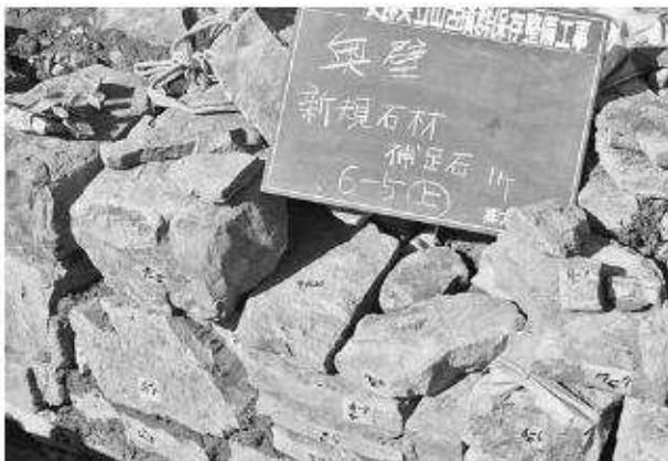
写真80 平成19年度石室修理工 2号墳奥壁積み直し状況⑨
