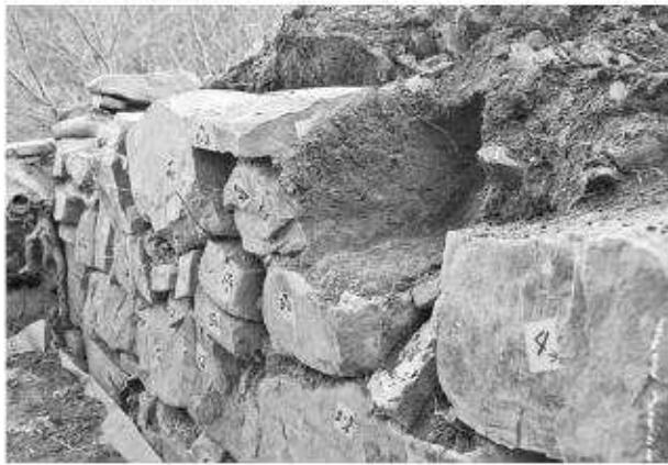
写真111 平成19年度石室修理工2号墳羨道西側壁解体
