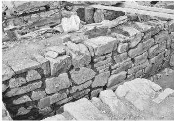
写真88 平成19年度石室修理工 2号墳奥壁積直完了状況②(南から)
