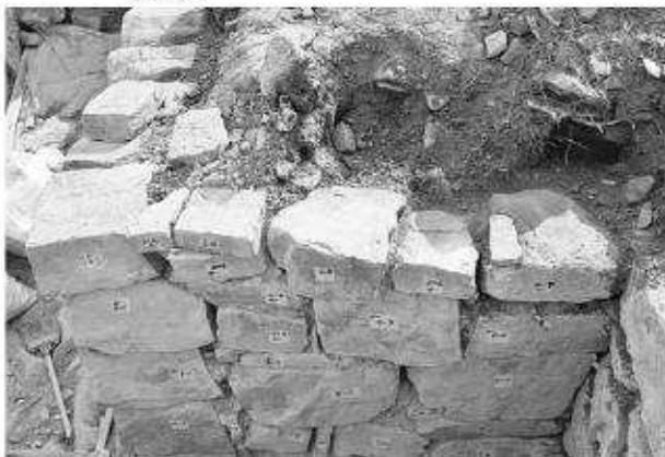
写真104 平成19年度石室修理工 2号墳羨道西側壁解体
