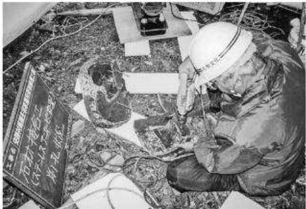
写真122 諸鼓修復工削孔状況
