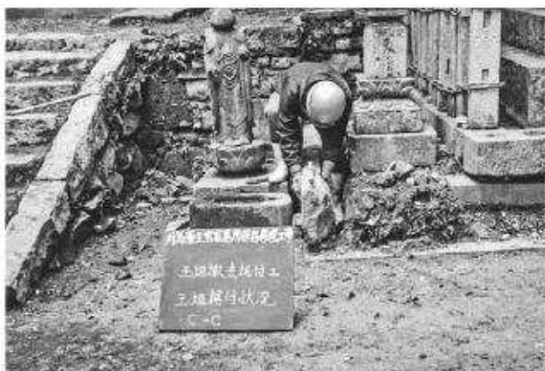
写真 6 玉垣修理工（高寿院殿）玉垣据付状況
