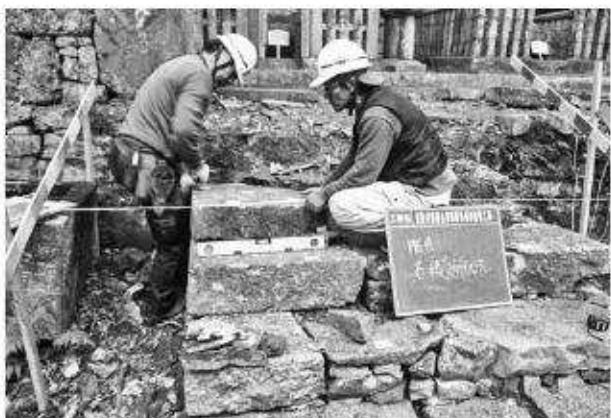
写真236 石垣修理工（中御靈屋）石段据付状況
