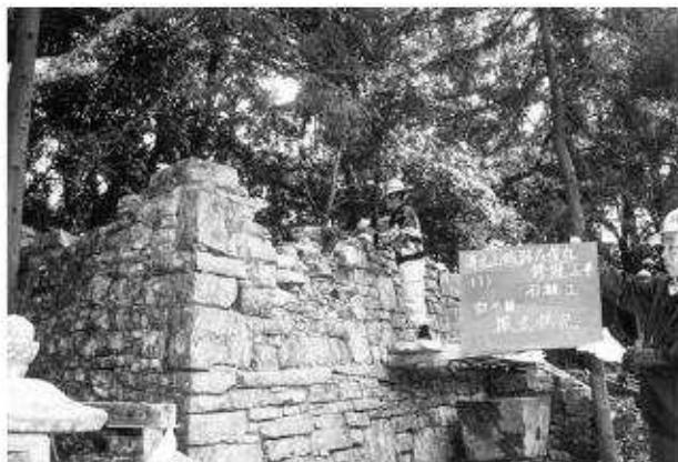
写真35 石垣修理工石垣解体状況
