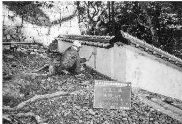
写真180 築地修理工（上御靈屋）漆喰下塗り状況
