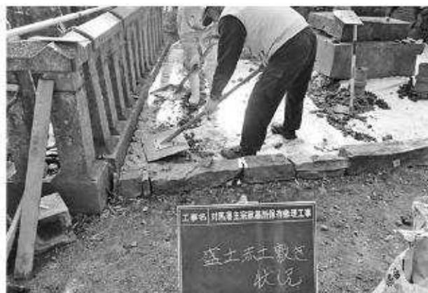
写真230 石垣修理工（中御靈屋）赤土盛土状況
