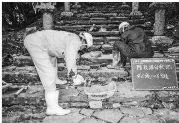
写真115 石段修理工（百雁木）石段据付状況
