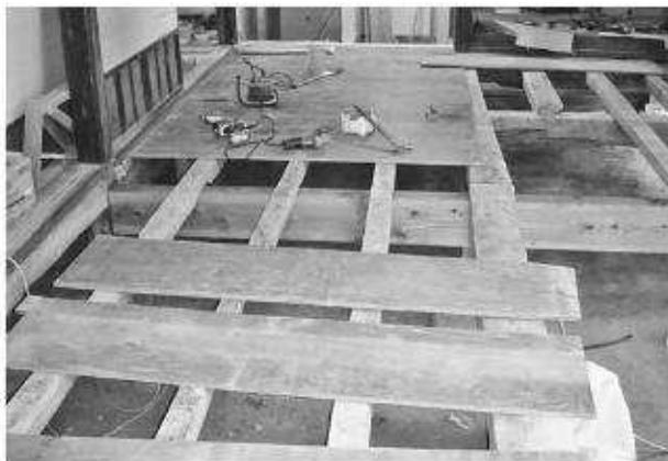
写真314 万松院庫裏改築工大引き取替状況
