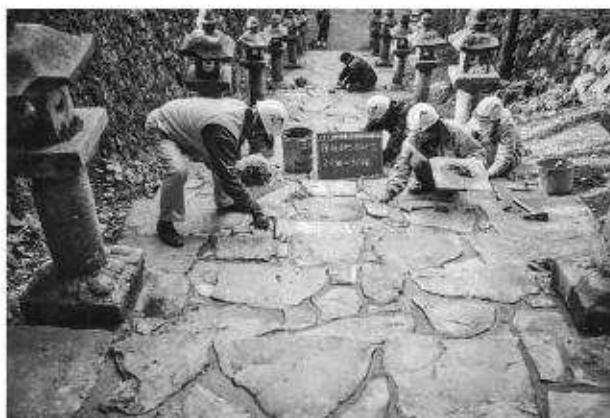
写真117 石段修理工（百雁木）目地仕上げ状況
