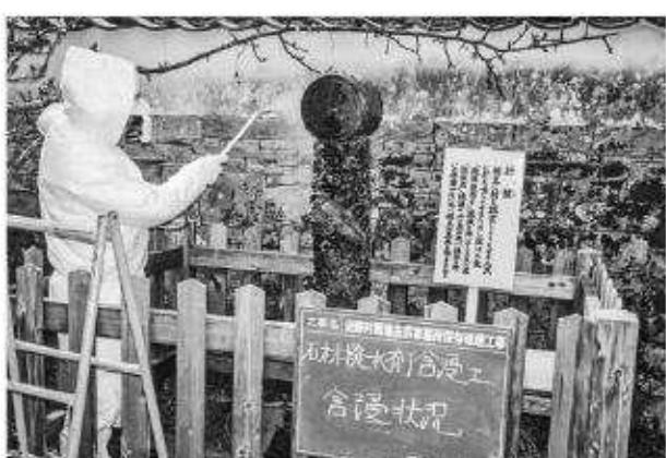
写真127 諸鼓修復工石材撥水処理施工状況
