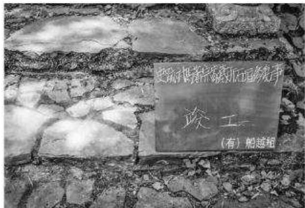
写真91 石段修復工完成
