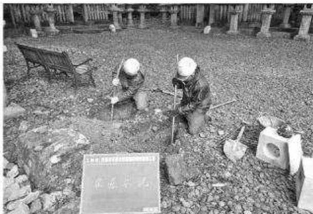
写真260 学習施設工説明板基礎床掘状況
