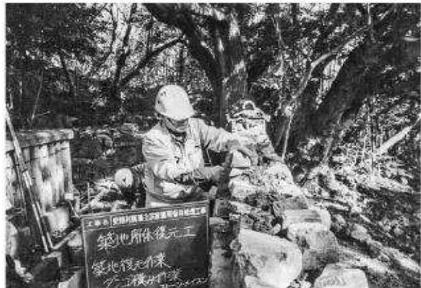
写真137 築地修理工（二面）ダンゴ積み状況
