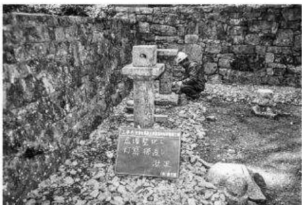
写真174 灯籠修理工（上御靈屋）据直状況
