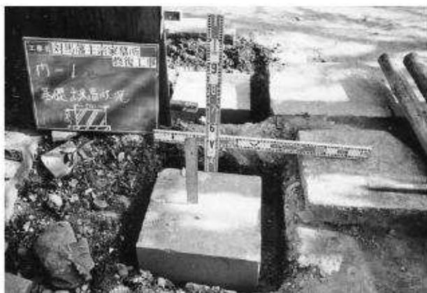
写真69 門修理工（くぐり門1）基礎コンクリート打設状況
