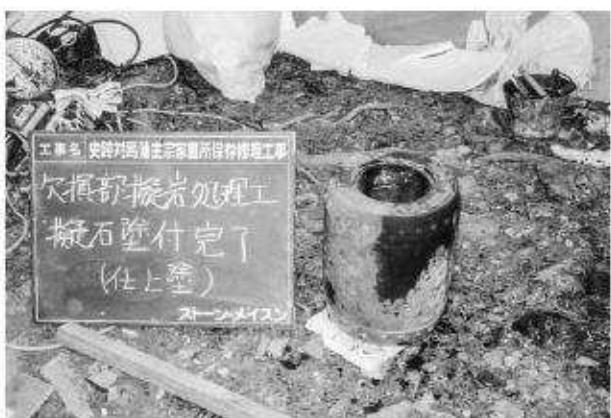
写真126 諸鼓修復工撮石処理完了
