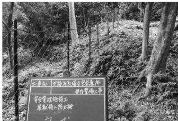
写真290 安全管理施設工害獸進入防止柵完成
