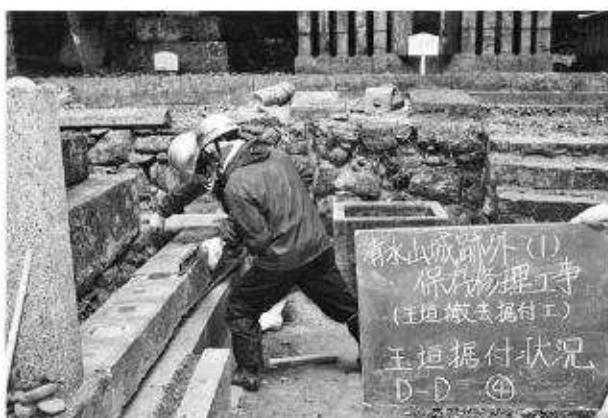
写真13 玉垣修理工（仙寿院殿）玉垣据付状況
