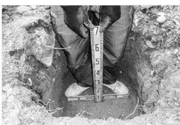
写真295 学習施設工道標基礎床掘出來形
