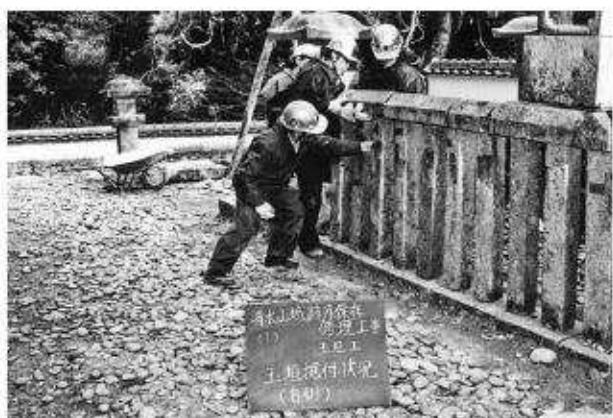
写真30 玉垣修理工玉垣据付状況
