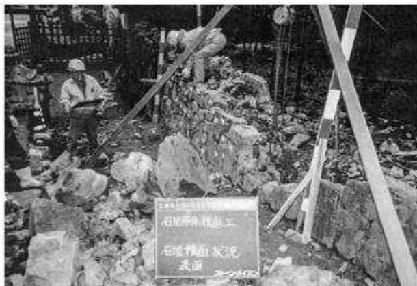
写真165 石垣修理工（百雁木）石垣積直状況
