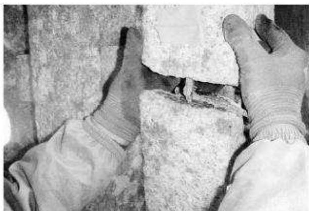
写真197 玉垣修理工柱接合状況
