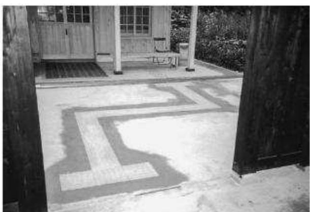
写真112 視覚障害者誘導マーク設置工完成
