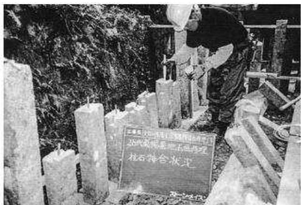
写真156 玉垣修理工（真常院殿）柱石接合状況
