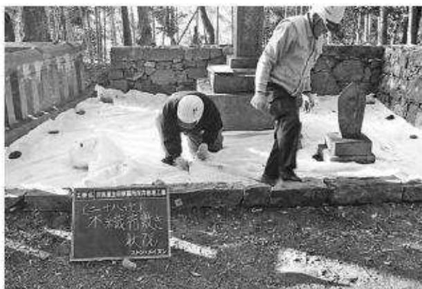
写真229 石垣修理工（中御靈屋）不織布敷設状況
