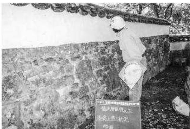
写真142 築地修理工（二面）漆喰上塗り状況
