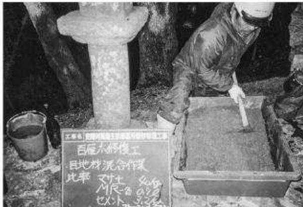
写真146 石段修理工（百雁木）目地材混合状況
