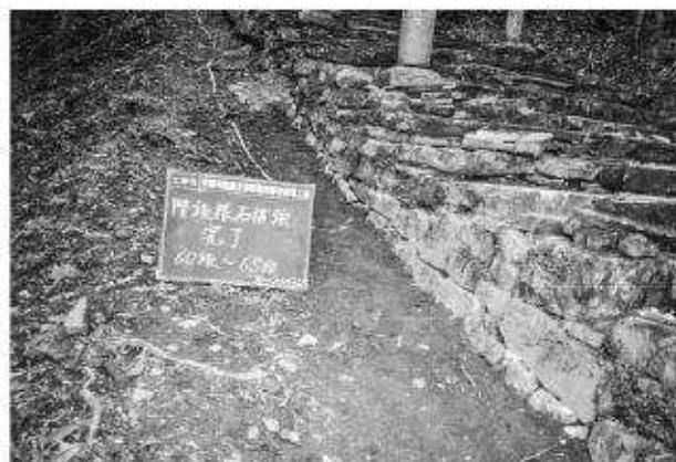
写真118 石段修理工（百雁木）階段補強状況
