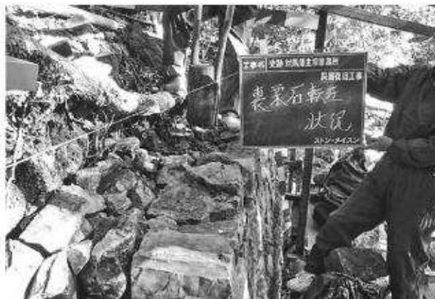
写真278 石垣修理工（上御靈屋）裏込栗石敷均し状況
