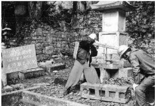
写真10 玉垣修理工（仙寿院殿）玉垣撤去状況
