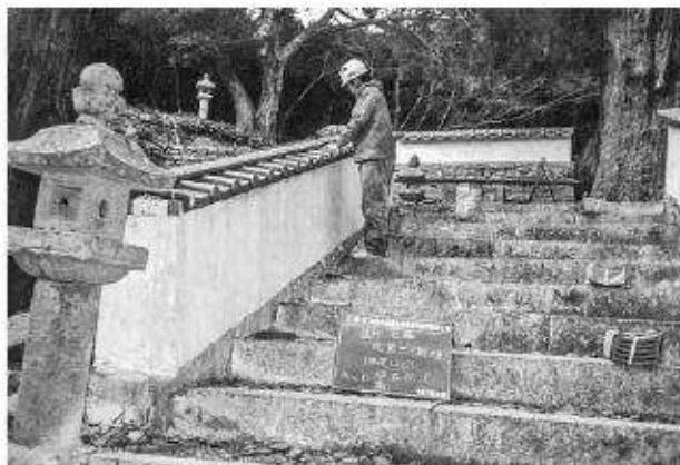
写真181 築地修理工（上御靈屋）瓦葺き状況
