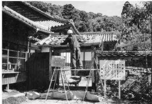
写真66 門修理工（くぐり門1）瓦降ろし状況
