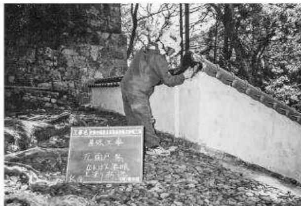
写真182 築地修理工（上御靈屋）瓦面戸黒漆喰上塗り状況
