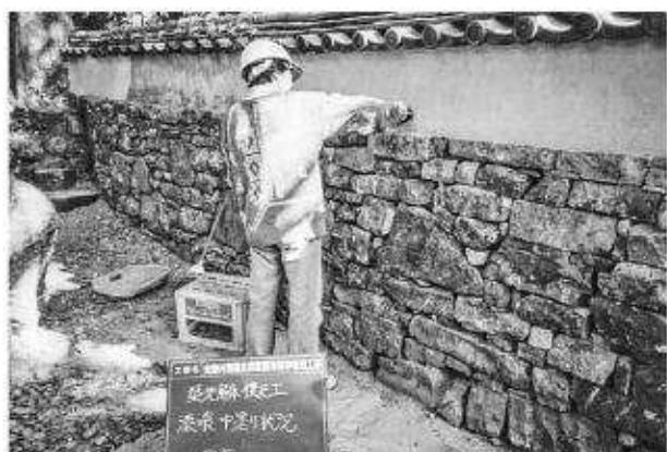
写真141 築地修理工（二面）漆喰中塗り状況
