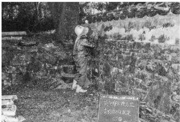
写真140 築地修理工（二面）漆喰剥がし状況
