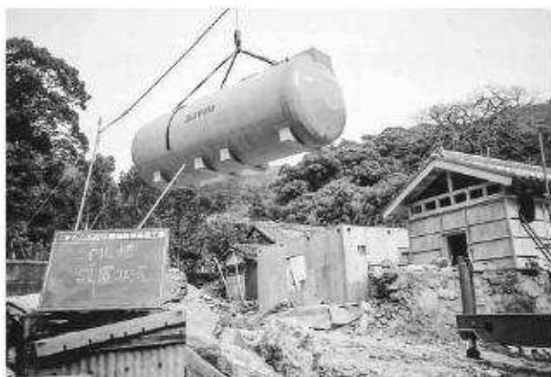
写真311 万松院休憩棟・便所棟浄化槽設置状況
