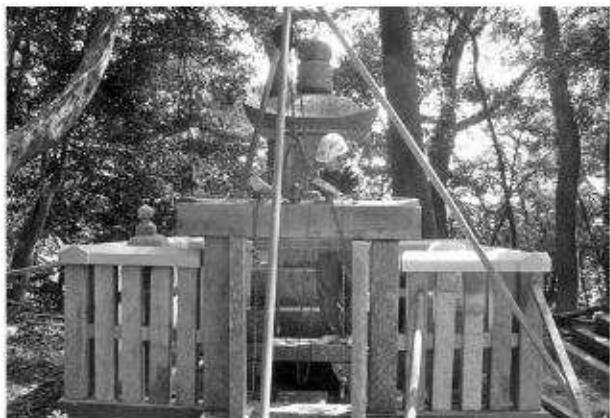
写真219 玉垣修理工（天樓院殿）框石据付状況
