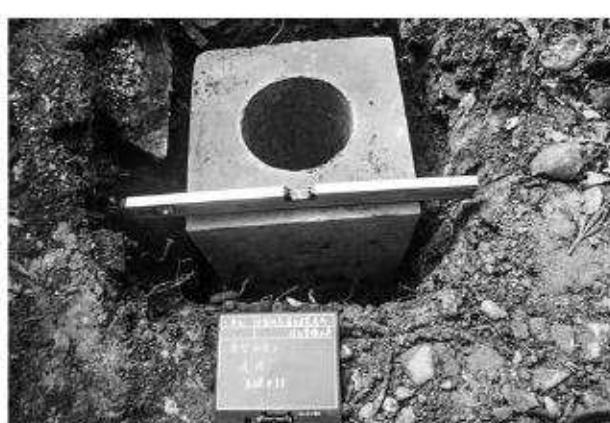
写真296 学習施設工道標基礎敷設状況
