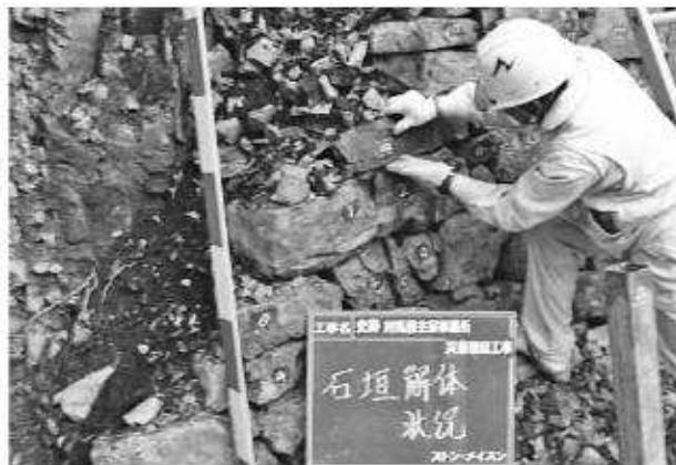
写真276 石垣修理工（上御靈屋）石垣解体状況
