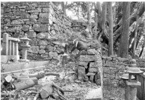
写真222 石垣修理工（中御靈屋）伐木状況
