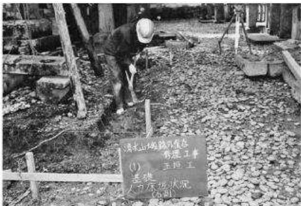
写真27 玉垣修理工人力掘削状況
