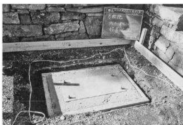
写真319 音声ガイダンスアンカーボルト設置
