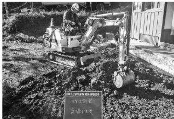
写真242 園路広場工（庫裏）真砂土舗装床掘状況
