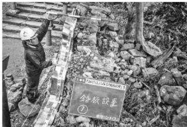
写真188 石垣修理工（百雁木）鉛板敷設状況
