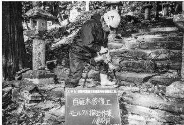
写真145 石段修理工（百雁木）モルタル撤去状況
