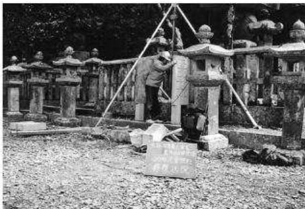
写真60 玉垣修理工（光雲院殿）石屏据付状況
