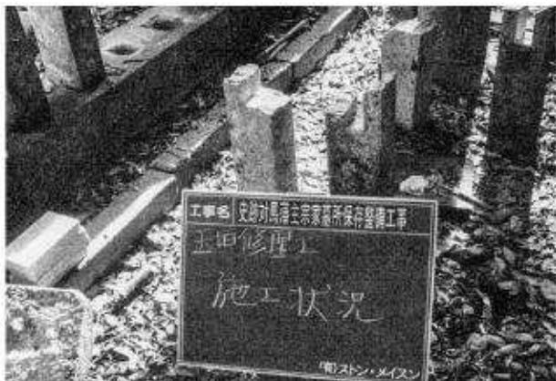
写真196 玉垣修理工ステンレスピン施工状況
