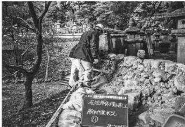
写真130 石垣修理工（八面）石垣解体状況
