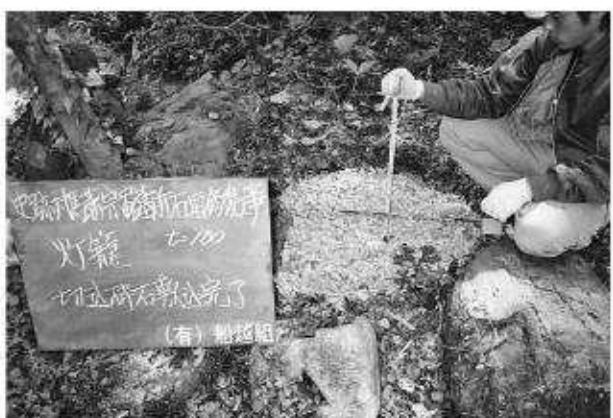
写真88 灯籠修理工基礎碎石状況
