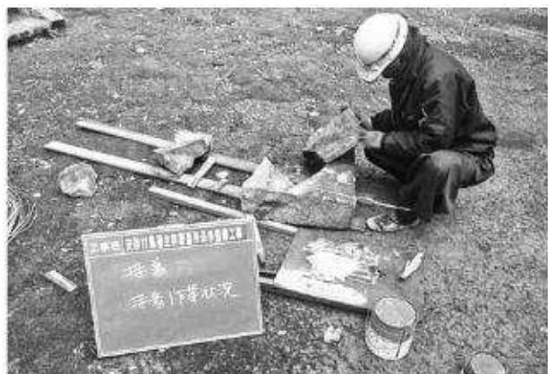
写真235 石垣修理工（中御靈屋）石材接着状況
