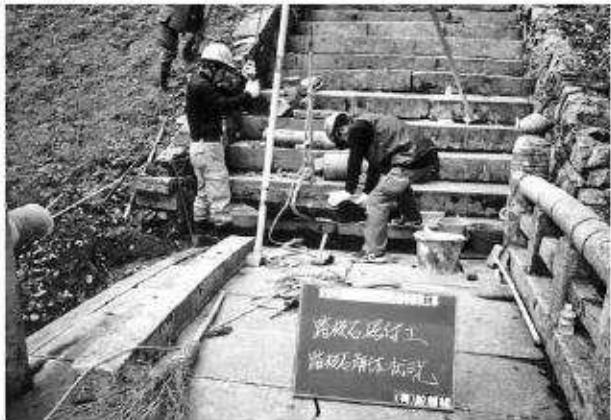
写真106 石橋修理工（上御靈屋）踏板石解体状況
