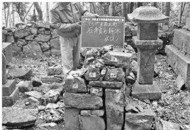
写真227 石垣修理工（中御靈屋）石垣解体状況
