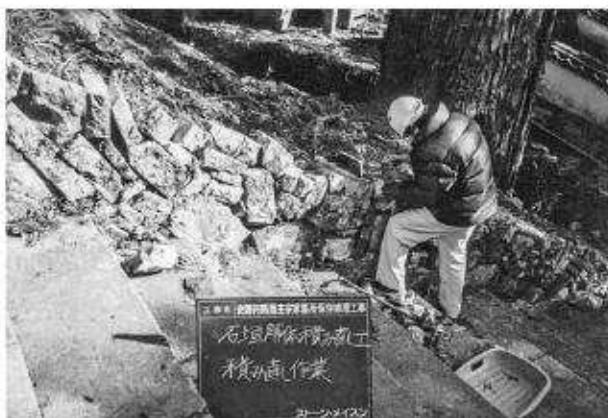
写真150 石垣修理工（上御靈屋）石垣積直状況
