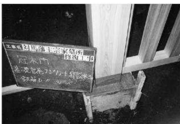
写真79 門修理工（冠木門）基礎コンクリート打設状況
