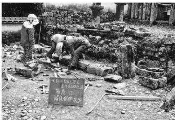
写真63 石段修理工（階段①）解体据直状況
