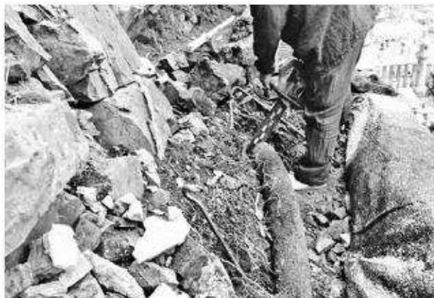
写真275 石垣修理工（上御靈屋）伐根状況
