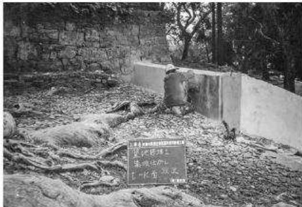
写真179 築地修理工（上御靈屋）漆喰剥がし状況
