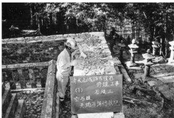
写真38 石垣修理工天端石据付状況
