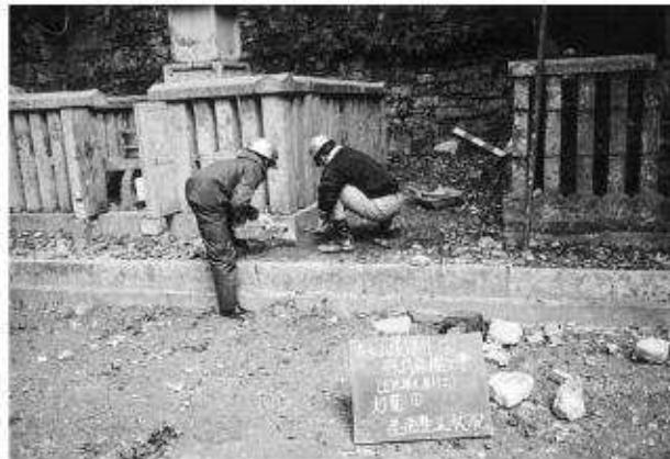
写真18 灯籠撤去据付基面整正状況
