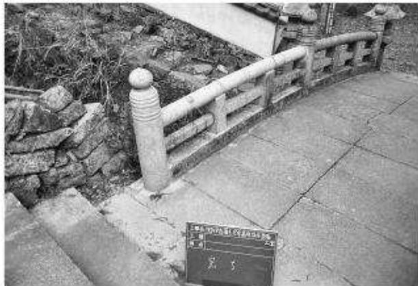
写真209 石橋修理工（裏御靈屋）完了
