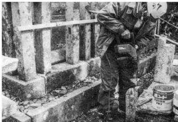
写真195 玉垣修理工ほぞ穴加工状況
