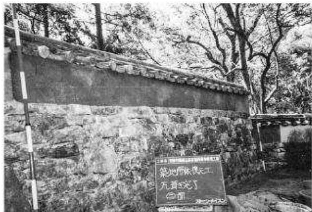
写真139 築地修理工（二面）瓦葺き完了
