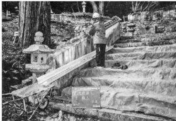
写真177 築地修理工（上御靈屋）瓦降ろし状況
