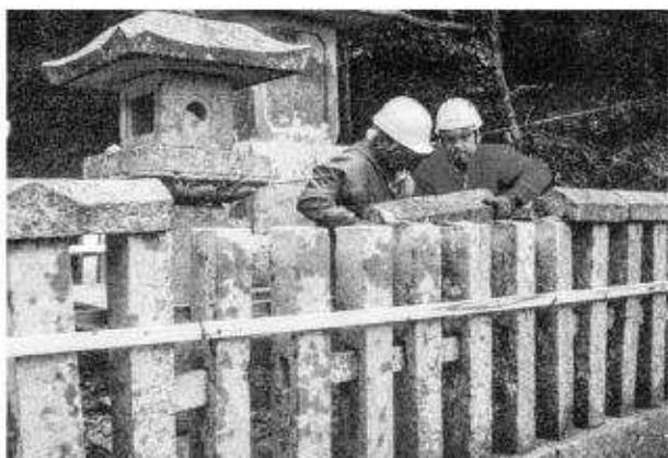
写真198 玉垣修理工笠石据付状況
