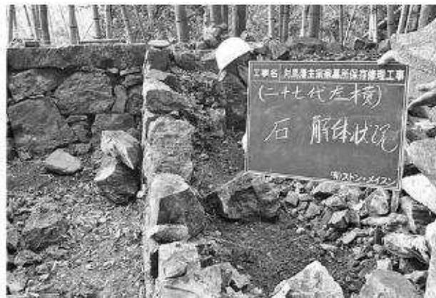
写真228 石垣修理工（中御靈屋）石垣解体状況
