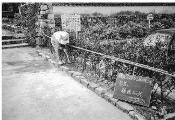
写真109 植栽工サザンカ植込状況
