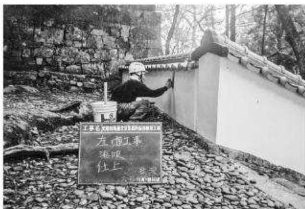
写真183 築地修理工（上御靈屋）漆喰仕上げ状況
