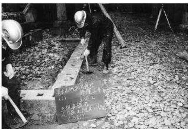
写真29 玉垣修理工埋め戻し状況
