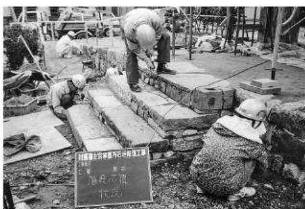
写真103 門修理工階段石積状況
