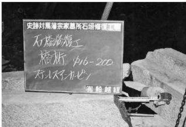
写真83 石橋修復工（上御靈屋）ステンレスアンカービン施工状況
