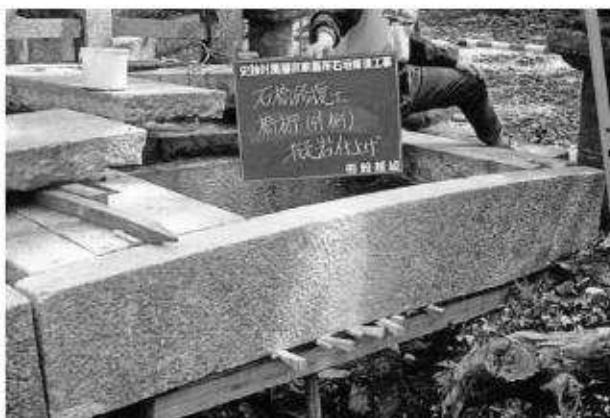
写真85 石橋修復工（上御靈屋）橋桁搬岩仕上げ状況
