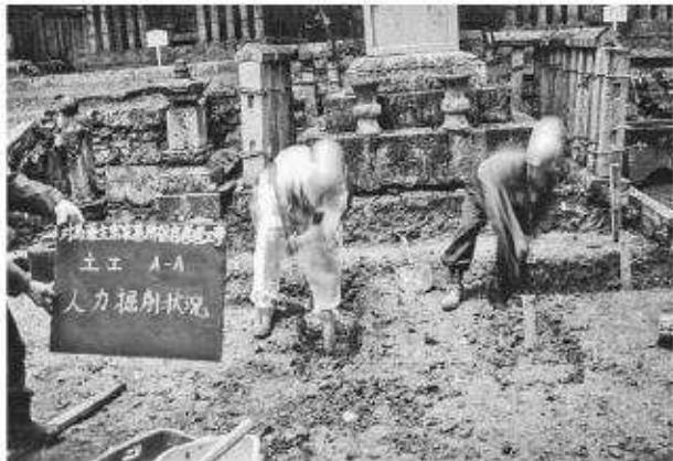
写真 2 玉垣修理工（高寿院殿）人力掘削状況
