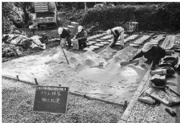
写真243 園路広場工（庫裏）真砂土舗装施工状況
