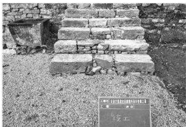
写真237 石垣修理工（中御靈屋）完成
