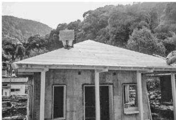
写真309 万松院休憩棟・便所棟野地板施工状況
