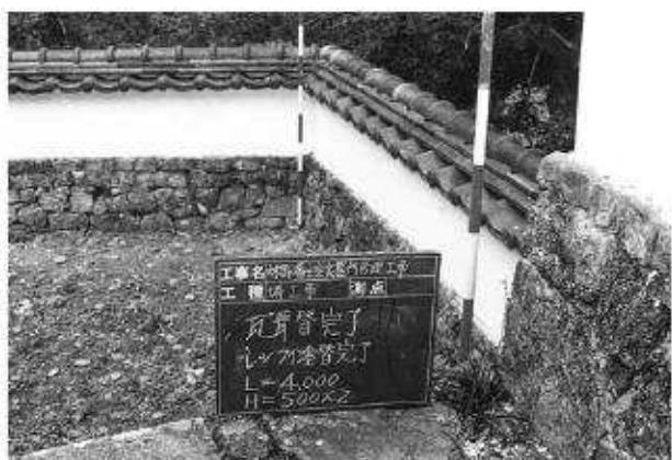
写真302 築地修理工（上御靈屋）完成
