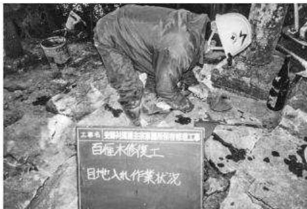
写真147 石段修理工（百雁木）目地仕上げ状況
