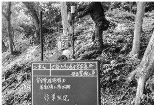
写真289 安全管理施設工害獸進入防止柵設置作業状況
