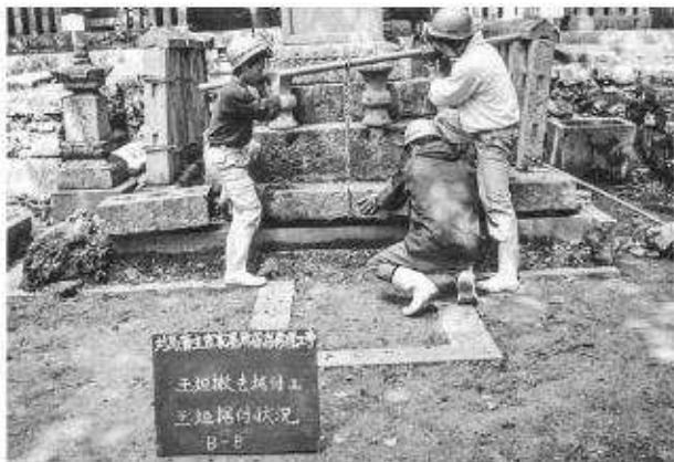
写真 4 玉垣修理工（高寿院殿）玉垣据付状況
