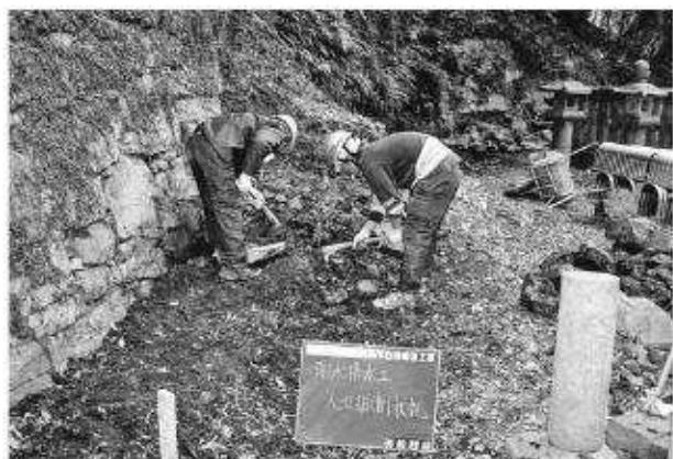
写真93 雨水排水工（上御靈屋）人力掘削状況
