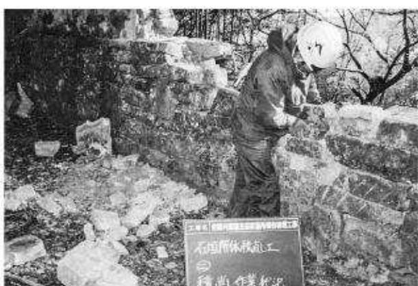
写真136 石垣修理工（二面）石垣積直状況
