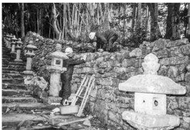
写真189 石垣修理工（百雁木）石垣積直状況
