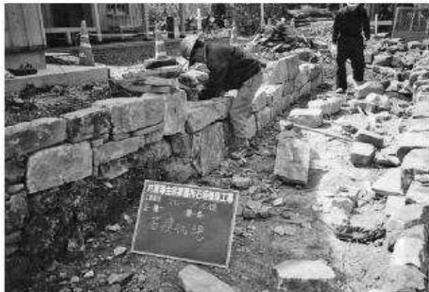
写真99 石垣修理工石垣積直状況
