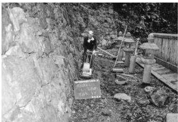
写真94 雨水排水工（上御靈屋）基面転圧状況
