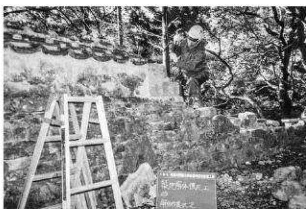
写真135 築地修理工（二面）築地解体状況
