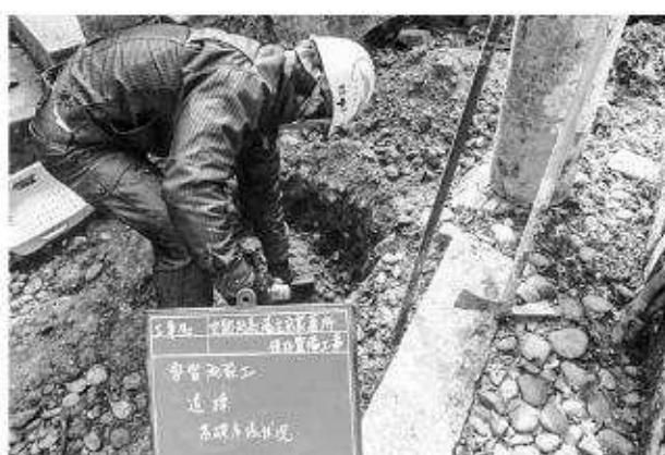
写真294 学習施設工道標基礎床掘状況
