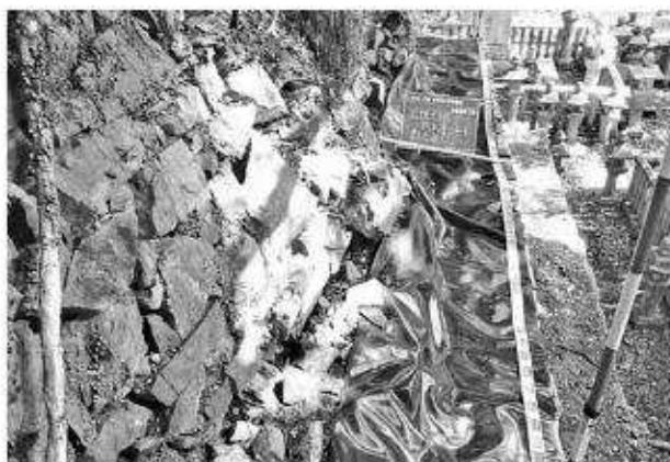
写真279 石垣修理工（上御靈屋）防水シート敷設状況
