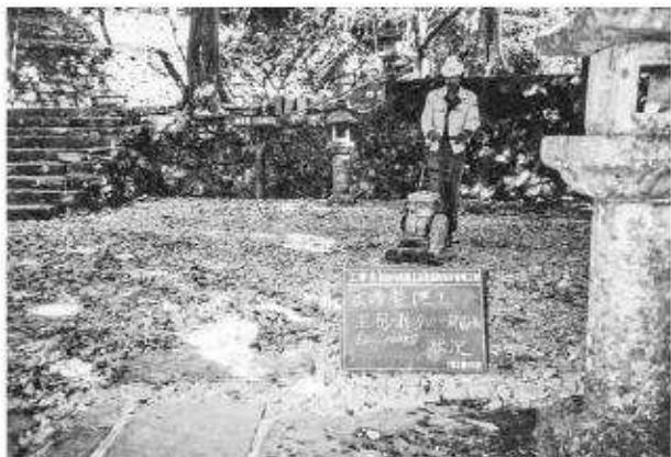
写真171 広場整地工（上御靈屋）玉砂利締固状況
