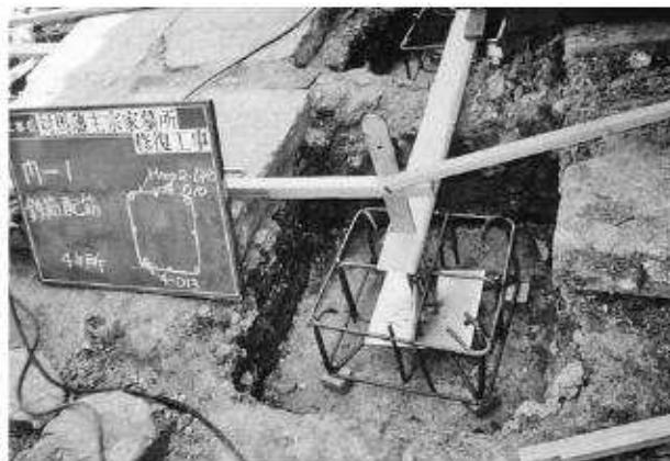
写真68 門修理工（くぐり門1）基礎鉄筋配筋状況
