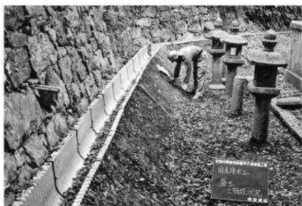
写真95 雨水排水工（上御靈屋）盛土土羽状況
