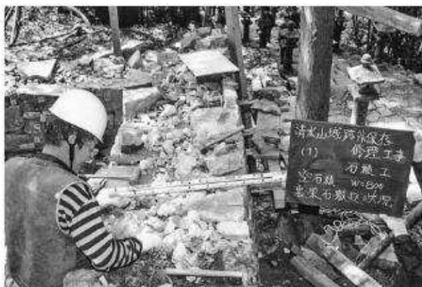
写真37 石垣修理工裏込栗石充填状況
