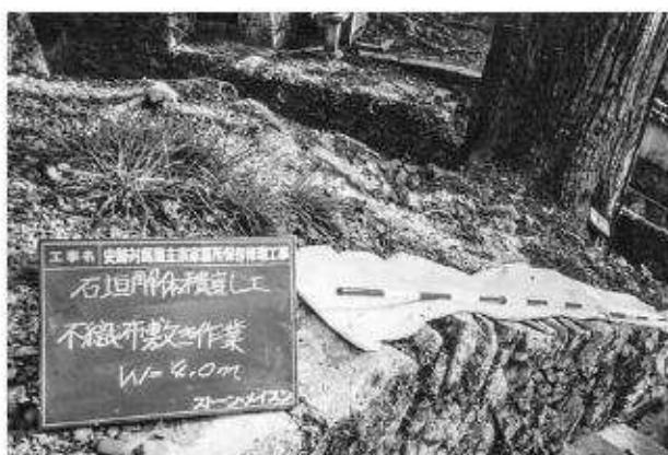
写真151 石垣修理工（上御靈屋）不織布敷設状況
