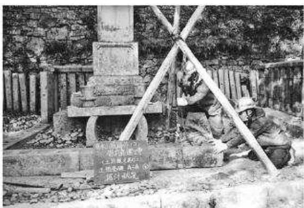
写真14 玉垣修理工（仙寿院殿）玉垣据付状況
