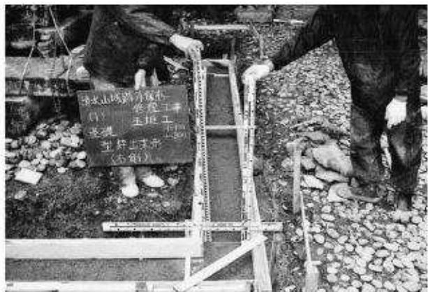
写真28 玉垣修理工型枠状況
