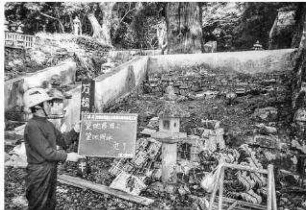
写真178 築地修理工（上御靈屋）解体完了
