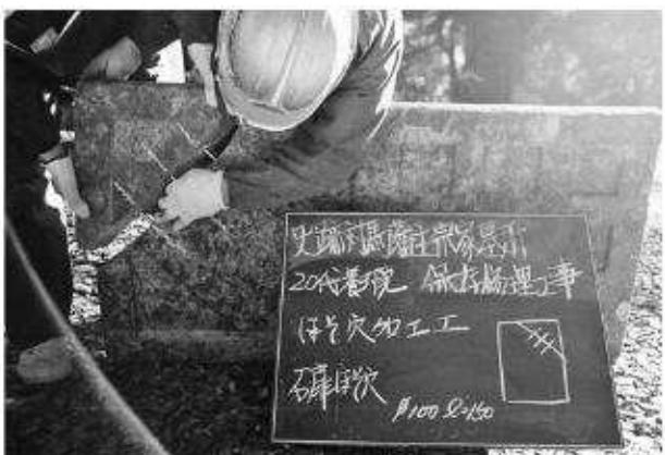
写真56 玉垣修理工（養玉院殿）石扉接着状況
