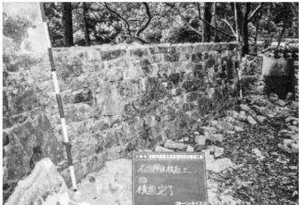
写真138 石垣修理工（二面）石垣積直完了
