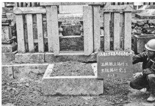
写真 5 玉垣修理工（高寿院殿）玉垣据付完了
