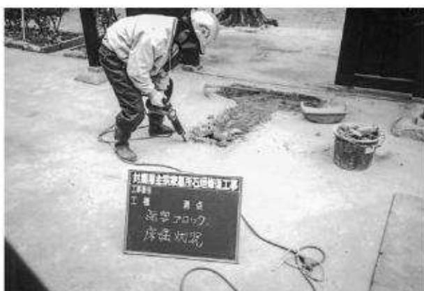
写真111 視覚障害者誘導マーク設置工床掘状況
