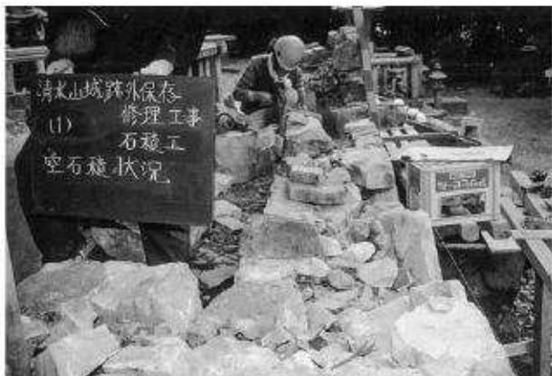
写真36 石垣修理工石垣積直状況
