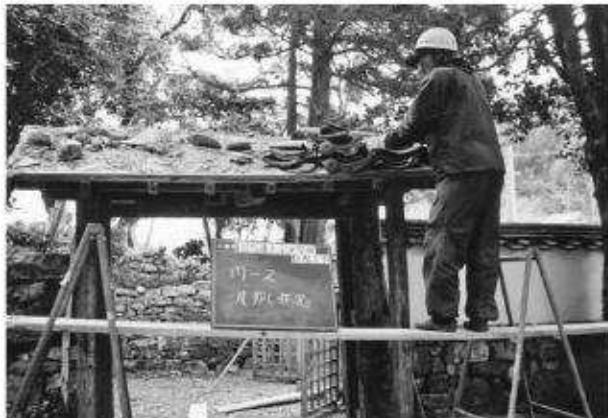
写真73 門修理工（くぐり門2）瓦降ろし状況
