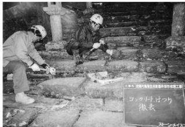
写真114 石段修理工(百雁木)コンクリートはつり状況
