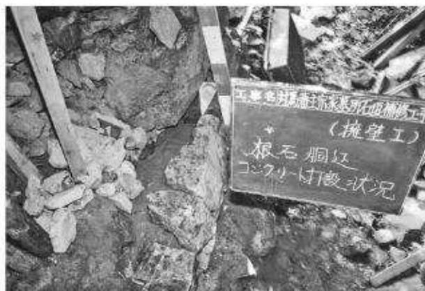
写真22 石垣修理工（上御靈屋）根石掘込コンクリート打設状況
