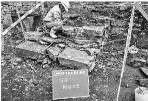
写真234 石垣修理工（中御靈屋）石段解体状況
