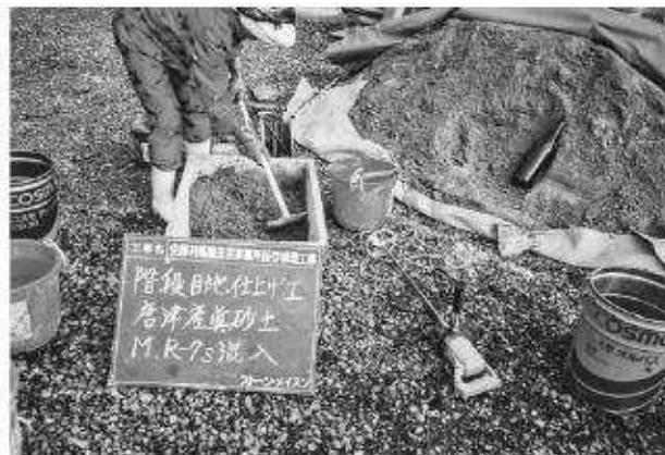
写真116 石段修理工（百雁木）目地材混合状況
