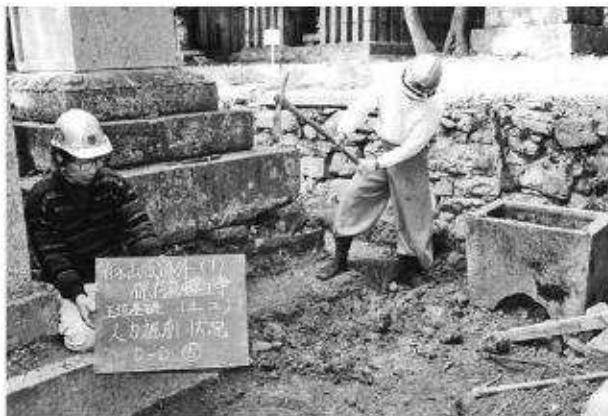
写真11 玉垣修理工（仙寿院殿）人力掘削状況
