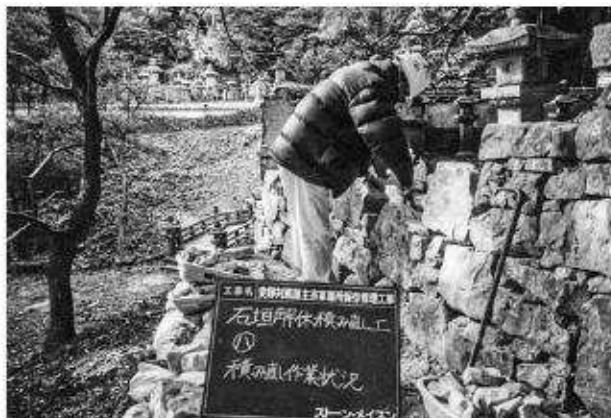
写真131 石垣修理工（八面）石垣積直状況
