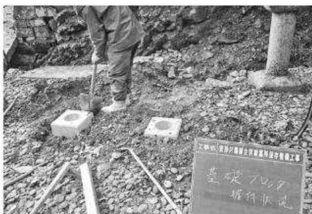
写真261 学習施設工説明板基礎ブロック据付状況
