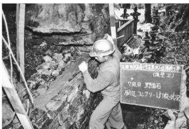
写真23 石垣修理工（上御靈屋）胴込コンクリート打設状況
