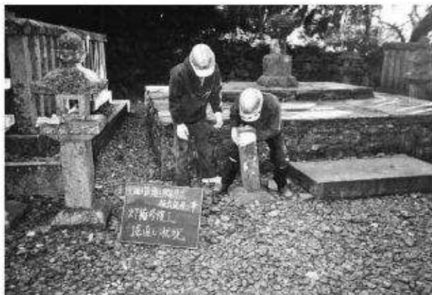
写真53 玉垣修理工（万松院殿）灯籠据直状況
