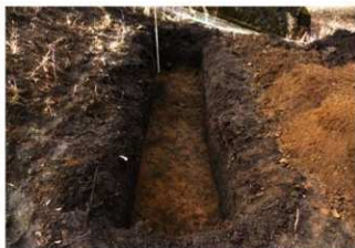
4 トレンチ完掘 (東から)
