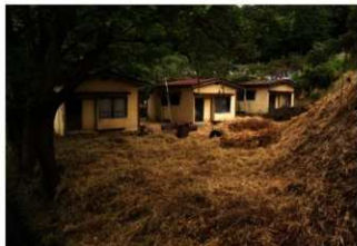
解体前の平屋住宅 (西から)
