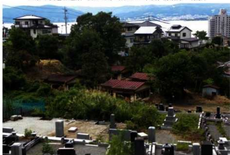
平屋建物解体前の様子（東から、平成28年夏撮影）
