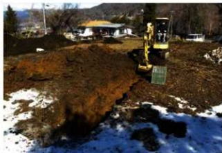
重機による表土掘削の様子 (3 トレンチ、南から)
