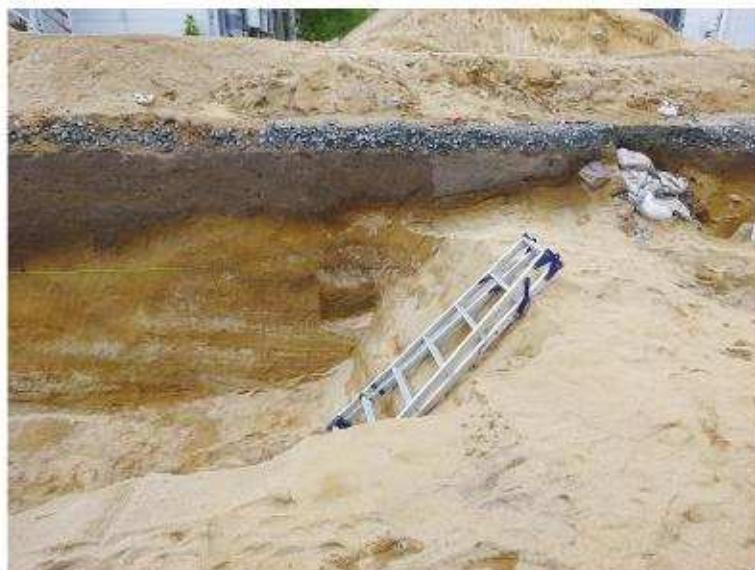
図2 GS-2の掘削地点（凹みの部分）付近の土層の写真（脚立の右側が石塁部分）
