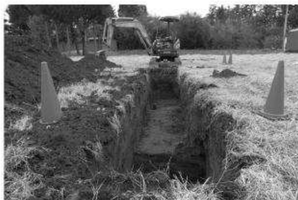
4 トレンチ調査状況（東から）
