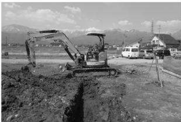
7 B トレンチ（東から）
