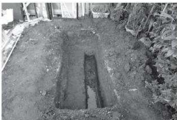
3 Bトレンチ(西から)
