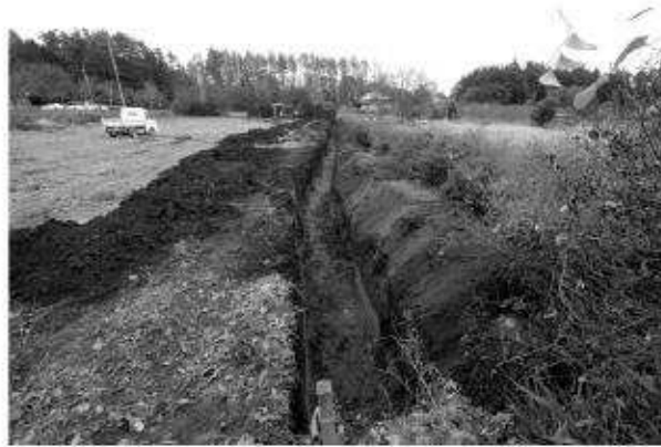
8 完掘状況（南から）
