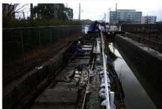
調査区南側掘削状況（北から）
