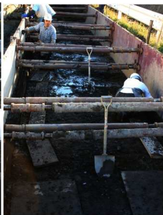
旧耕土掘削状況（北から）
