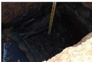
試掘坑 27 土層状況
