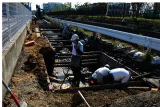
作業状況（北から）
