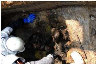
SK01 掘削状況（東から）
