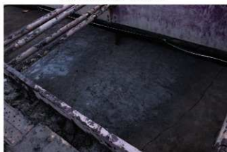
大溝1 検出状況（北東から）
