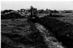
平成12年度詳細分布調査 試掘坑掘削
