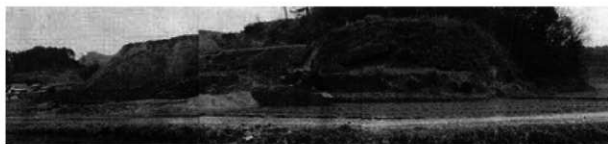
住宅造成工事中の状況（南から）
