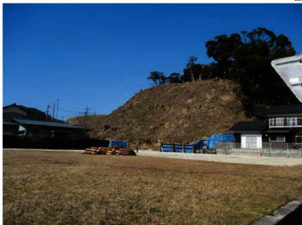
南東側斜面 調査前状況（東から）
