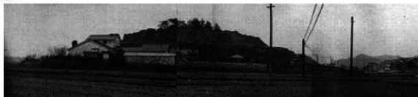
住宅造成工事中の状況（北から）
