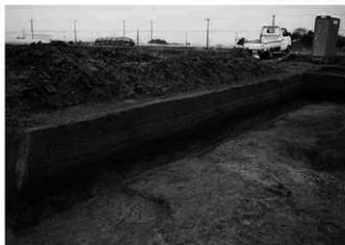
トレンチ北半西壁(南東より)
