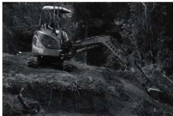
7. 掘削作業風景 (北東→)
