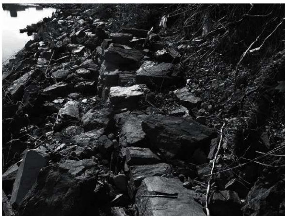
2 ②地点 石積と護岸捨石(北から)
