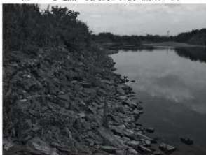
図 49 ④地点 杭列及び護岸捨石（南から）
