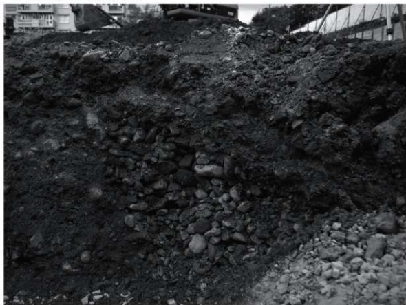
2 No 9-11: 西側石垣裏込め (南から)
