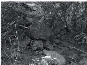
図 50 ⑤地点 石積（南東から）
