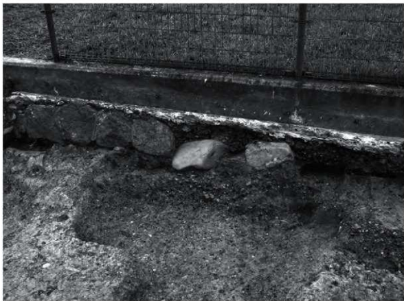
3 根固め(壺掘地業) 8 (南東から)
