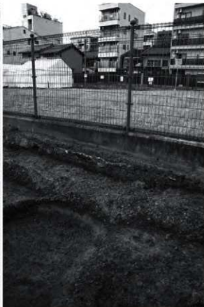
2 根固め(壺掘地業) 9 (南東から)
