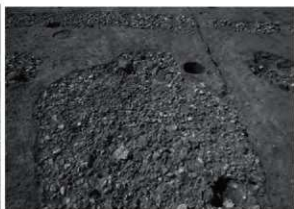
2 壺地業81及び77検出（北から）
