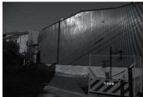
図3 調査前全景 (南東から)
