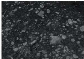
4 路面3近接風景（北東から）
