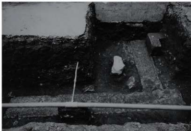
図10 延祿堂西縁北端の階段 (調査1③地点)
