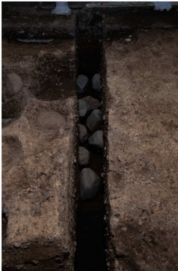
根固め（壱掘地業）2（北から）
