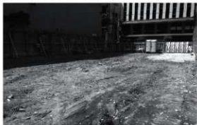
図3 調査前全景（北から）
