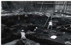
図4 作業風景（南西から）
