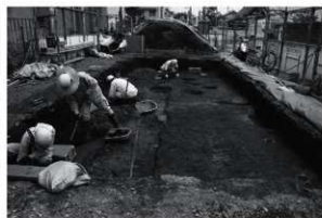
図4 作業風景(北から)
