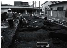
図3 作業風景（東から）
