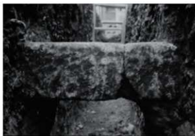
図8 延祿堂東縁延石 (調査1①地点)
