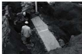
図5 埋戻し作業風景（北から）
