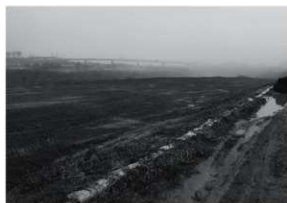
図3 埋戻し後全景（南西から）
