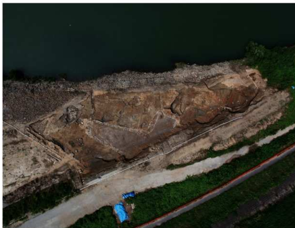
2 調査区全景（空撮）
