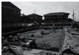
図3 調査風景(北西から)
